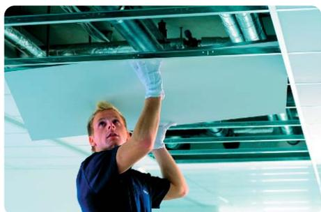
La linea principale per l'acqua di riscaldamento e raffrescamento, le condutture per l'impianto di condizionamento, il cablaggio, le condutture per gli estintori, ecc. possono essere installati nello spazio al di sopra del controsoffitto.
