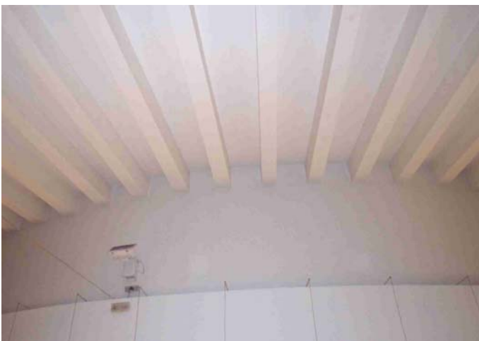
2004 - Vista delle travi del solaio, sopra l'emiciclo, lato sud-ovest Fonte: Archivio Grafite DGA
