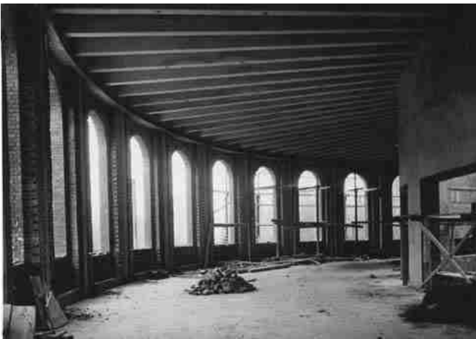
1932 / 1933 - I lavori di costruzione al primo piano Fonte: Archivio fotografico - Fondazione La Triennale di Milano
