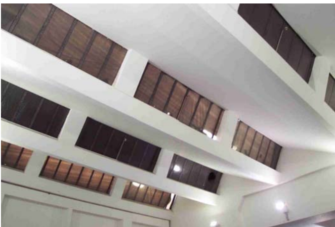
2004 - Anche per gli shed è prevista la sostituzione del sistema di oscuramento, a cui si aggiunge la sostituzione delle lastre di vetro in copertura, mentre viene mantenuto il serramento originale Fonte: Archivio aMDL
