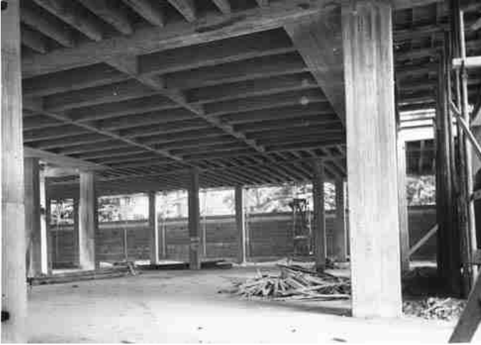
1932 / 1933 - I lavori di costruzione al piano terreno Fonte: Archivio fotografico - Fondazione La Triennale di Milano
