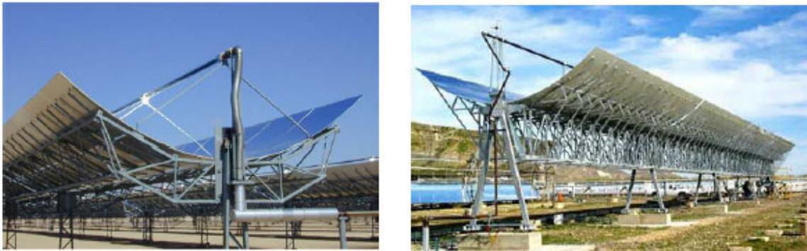
Figura 12 – Differenti strutture di supporto di collettori parabolici lineari
