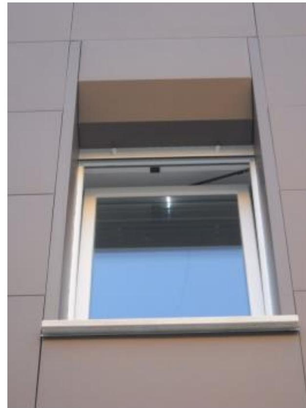
Isotec Parete sp. 120 mm abbinato a lastre in EPS sp. 120 mm. Rivestimento con lastre in lamiera a cassetta.
