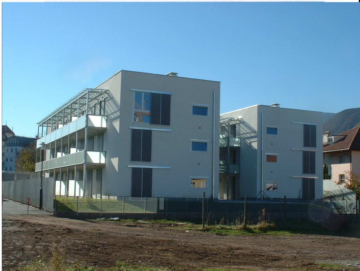
Gebäude Wohnbauinstitut in Eppan mit 16 Wohn. Edificio IPES a Appiano con 16 alloggi
