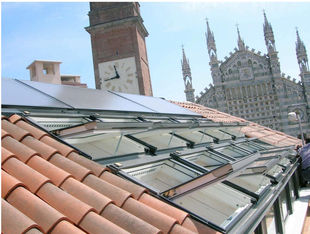
Notevole importanza per la riuscita del recupero è stata data alla scelta degli infissi. Per soddisfare i presupposti tecnico-architettonici si è scelto di impiegare le finestre **FTU/D L3 di FAKRO**, che offrono prestazioni rilevanti per l'insonorizzazione degli ambienti interni.
