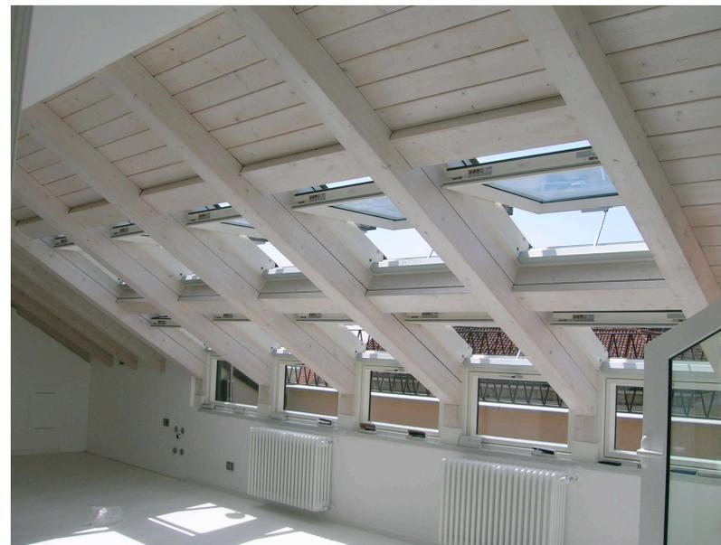
Le finestre combinate **FTU/D L3**, in legno di pino e rifinite con la vernice poliuretanica di colore bianco, si caratterizzano, inoltre, per una maggiore resistenza all'umidità.
