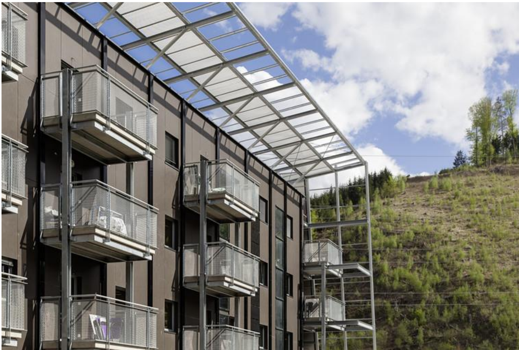
Complesso residenziale Johann-Böhm-Straße Kapfenberg/A 2013
