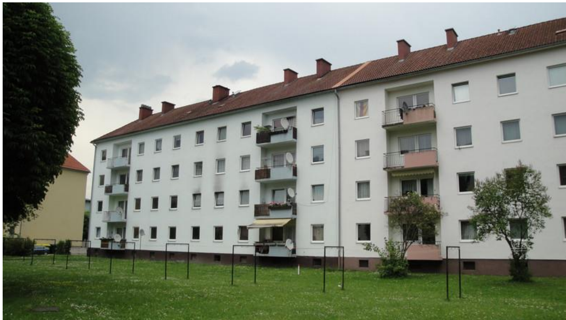
Complesso residenziale Johann-Böhm-Straße Kapfenberg/A 2013
