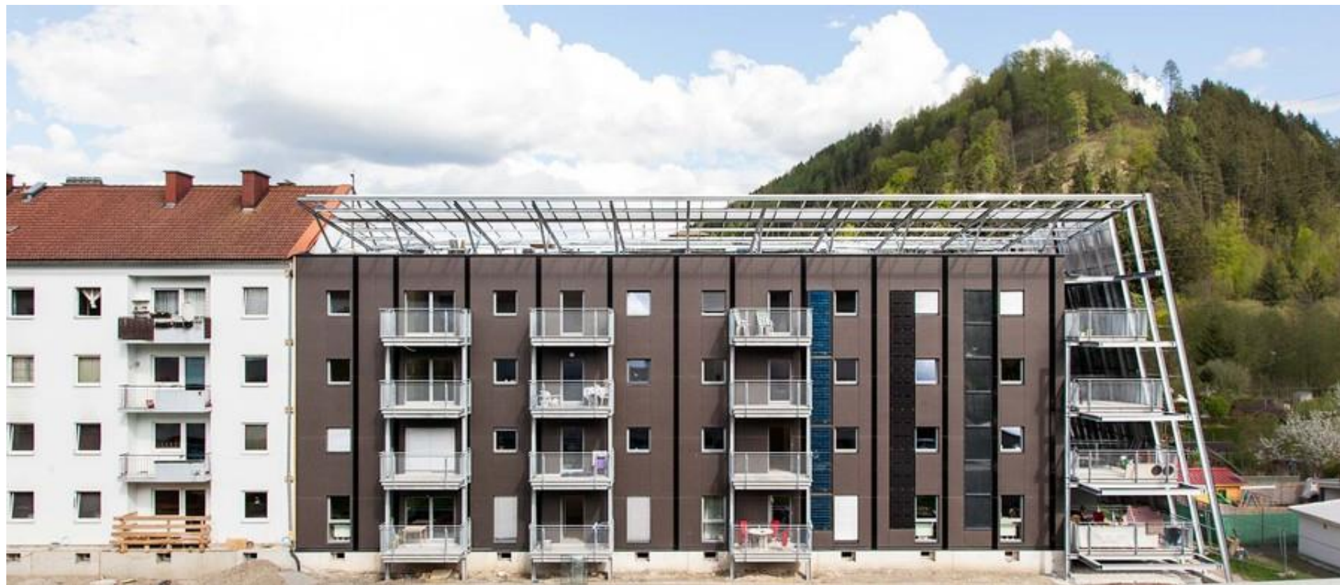
Complesso residenziale Johann-Böhm-Straße Kapfenberg/A 2013
