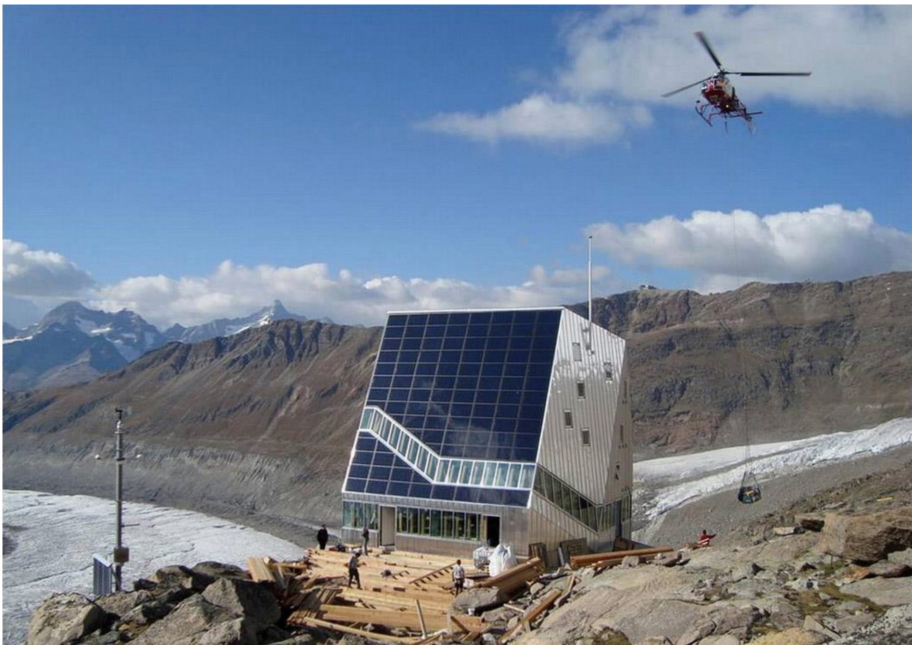
Die Neue Monte Rosa-Hütte (CH) 2883 m
