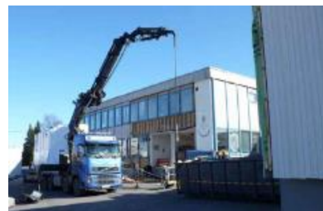
Retrofit energetico Involucroprogetto Tes Energy Facade, 2009-2011
