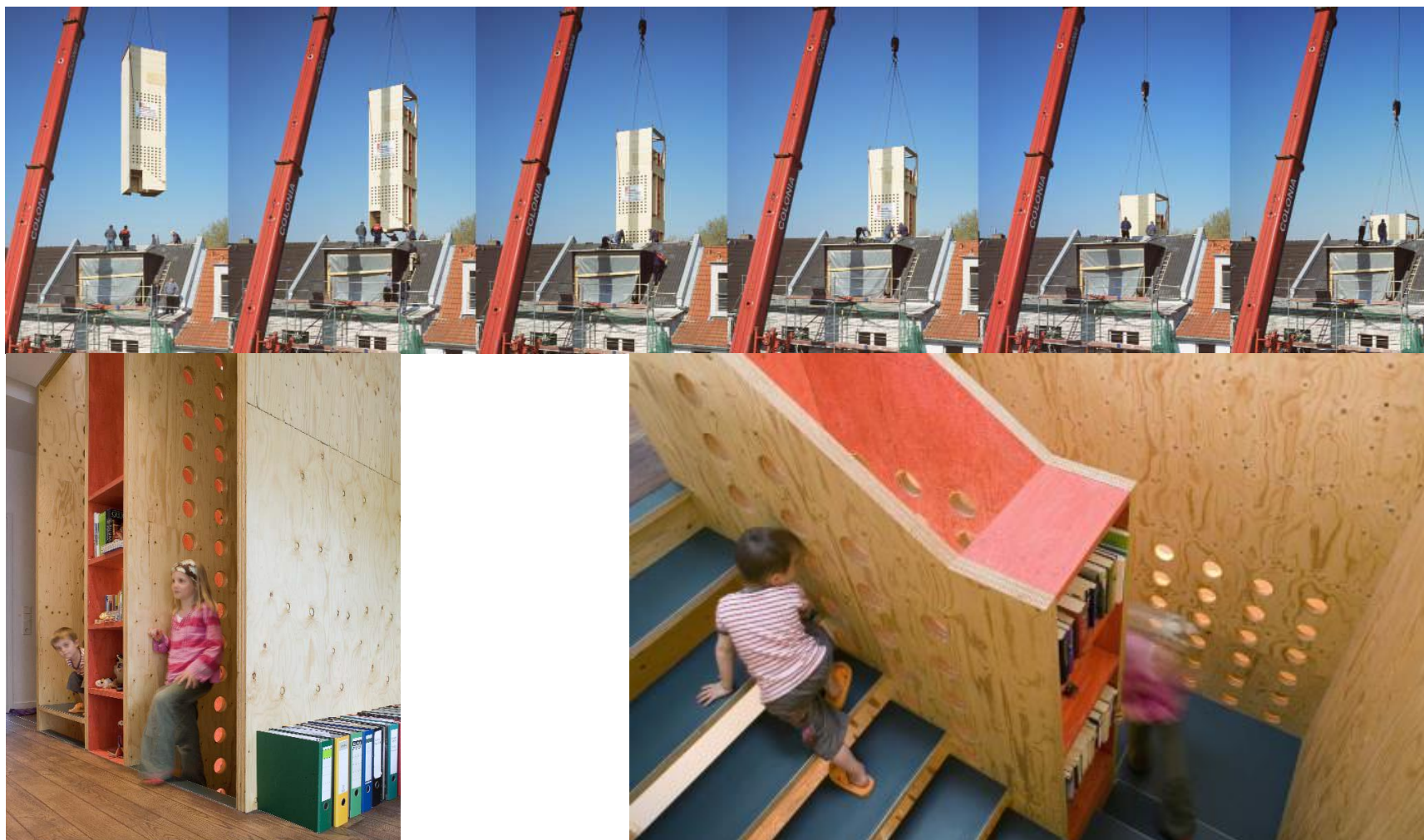
Projekt | Project: Neo Leo / wohnen vertikal Ort | Location: Köln, Germany Bauherr | Client: Marlies und Michael Schmitz-Kneuper Architekten | Architects: lüderwaldt verhoff architekten , Köln Mitarbeiter | Staff Caroline Wend © Fotos | Photos: Lukas Roth URL: www.luederwaldt-verhoff.de Fertigstellung | Completion: 2005 Nutzfläche | Area: 210 m 2
