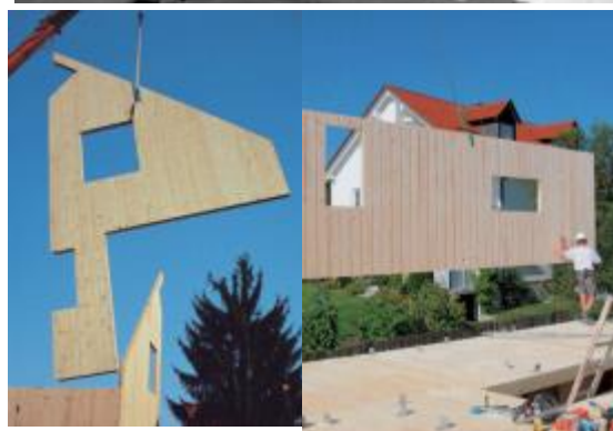
PANNELLI PORTANTI MASSICCI Fonte: www.klh.at
