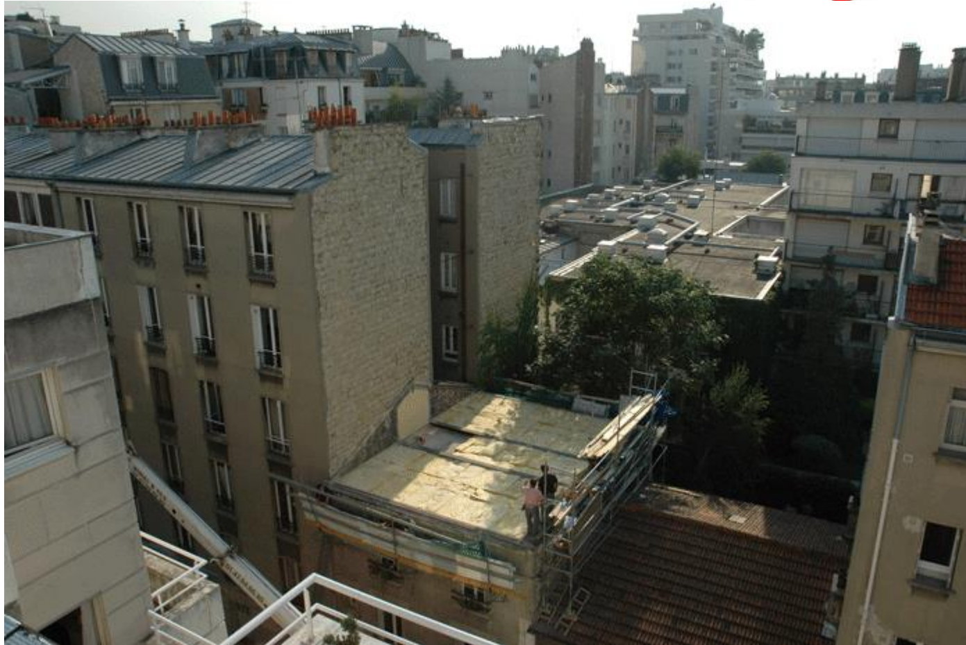
Immagini delle fasi costruttive dell'opera
