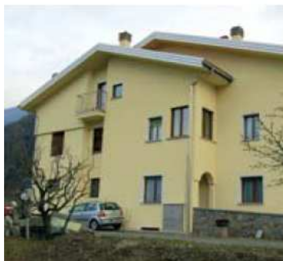
Tresenda di Teglio (Sondrio), Via Falck • Anno di esecuzione dell'isolamento a cappotto: 2007 • Prodotto applicato: STYROFOAM ETICS • Spessore: 10 cm - Sistema MAPETHERM
