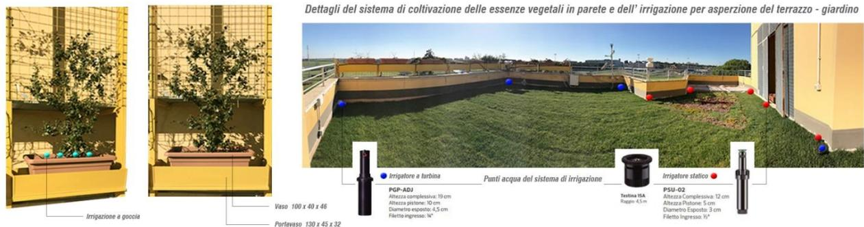
**Figura 1 Particolare del prototipo tetto-giardino sull'edificio Scuola delle Energie**
