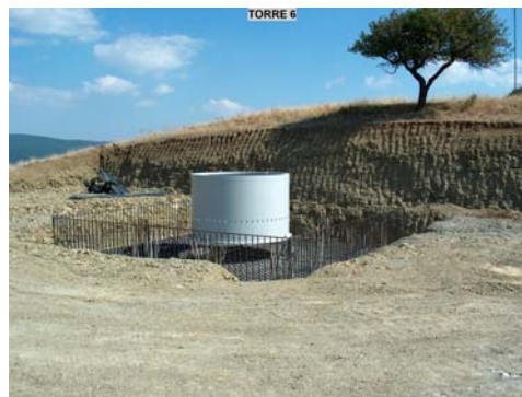
Fondazioni e posa del concio di torre (fonte: Energia Sud)
