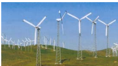
Impianti con torri a traliccio (Fonte: BNL etica e sociale)
