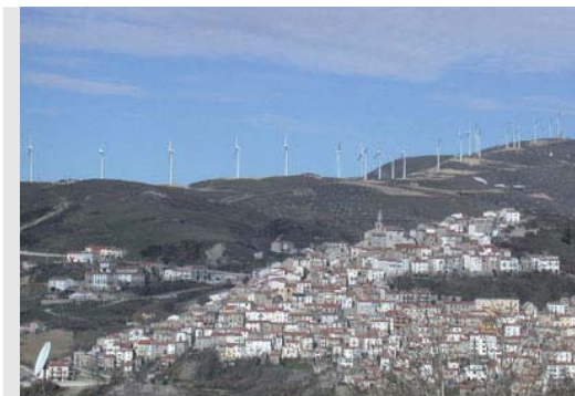
Torri eoliche nei pressi di un centro abitato (Fonte: ricerche internet)
