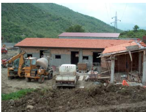
Cabina elettrica (Fonte: Energia Sud)
