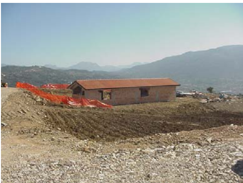
Piazzola predisposta per l'installazione della torre (Fonte: www.abnwindenergy.it )
