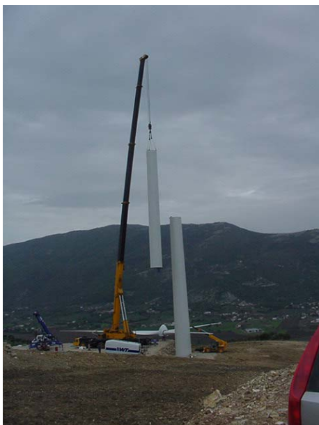
Montaggio di una torre eolica (Fonte: www.abnwindenergy.it )
