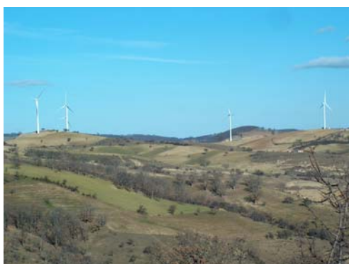
Impianto dopo i lavori (fonte: Energia Sud)
