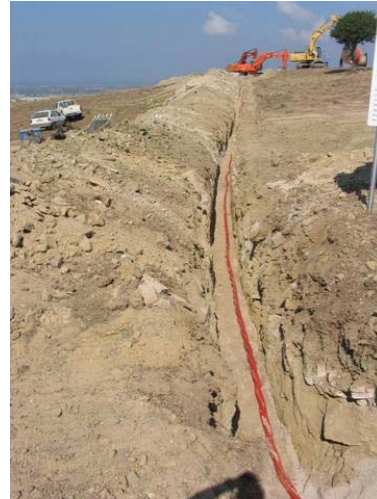
Scavo e predisposizione della linea elettrica (Fonte: www.abnwindenergy.it )
