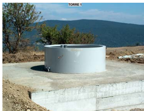
Fondazioni e primo concio di torre (fonte: Energia Sud)
