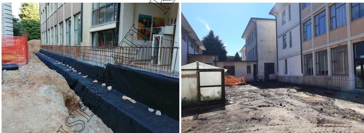
Figura 20: Nuove fondazioni per il cappotto sismico e ferri di ripresa
