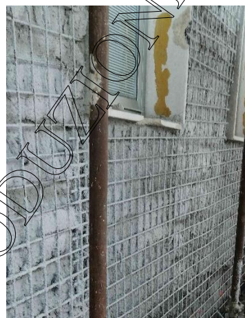
Figura 24: Posizionamento rete elettrosaldata e spruzzatura del betoncino di livellamento
