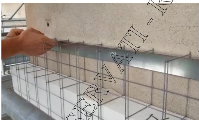
Figura 25: Posizionamento casseri del cappotto armato e finitura
