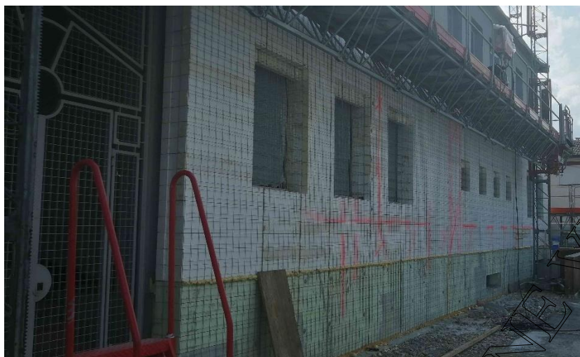
Figura 21: Cappotto di piano terra completato
