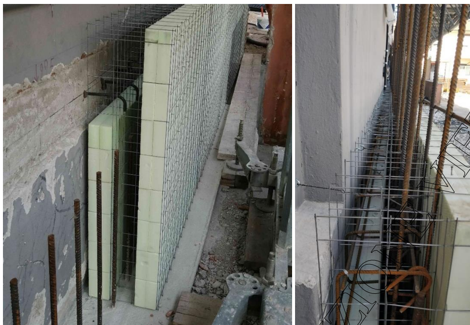
Figura 18: Partenza del cappotto dalla fondazione, si notano i casseri con XPS in partenza
