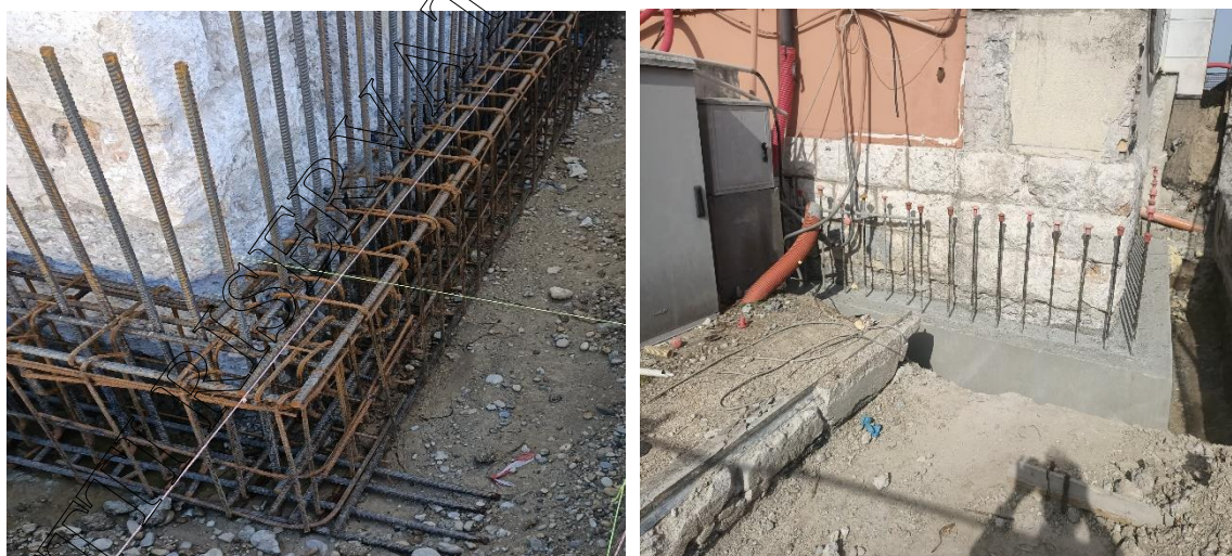
Figura 17: Nuove fondazioni per il cappotto sismico
