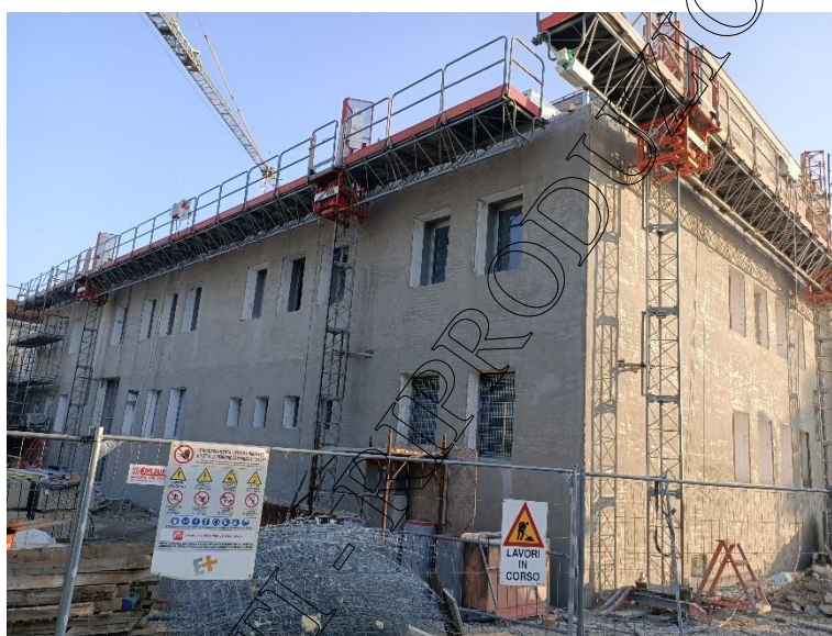
Figura 22: Finitura cappotto sismico
