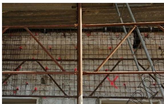
Figura 24: Posizionamento rete elettrosaldata e spruzzatura del betoncino di livellamento
