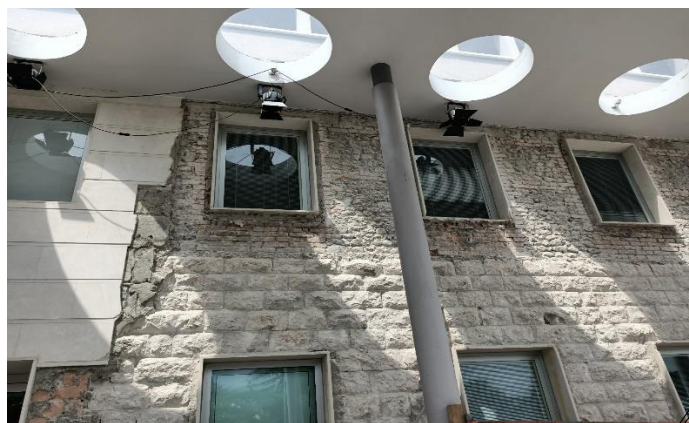
Figura 23: Rimozione del rivestimento lapideo
