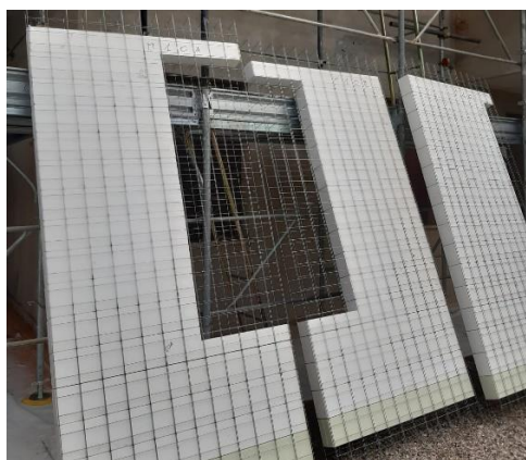
Figura 25: Posizionamento casseri del cappotto armato e finitura
