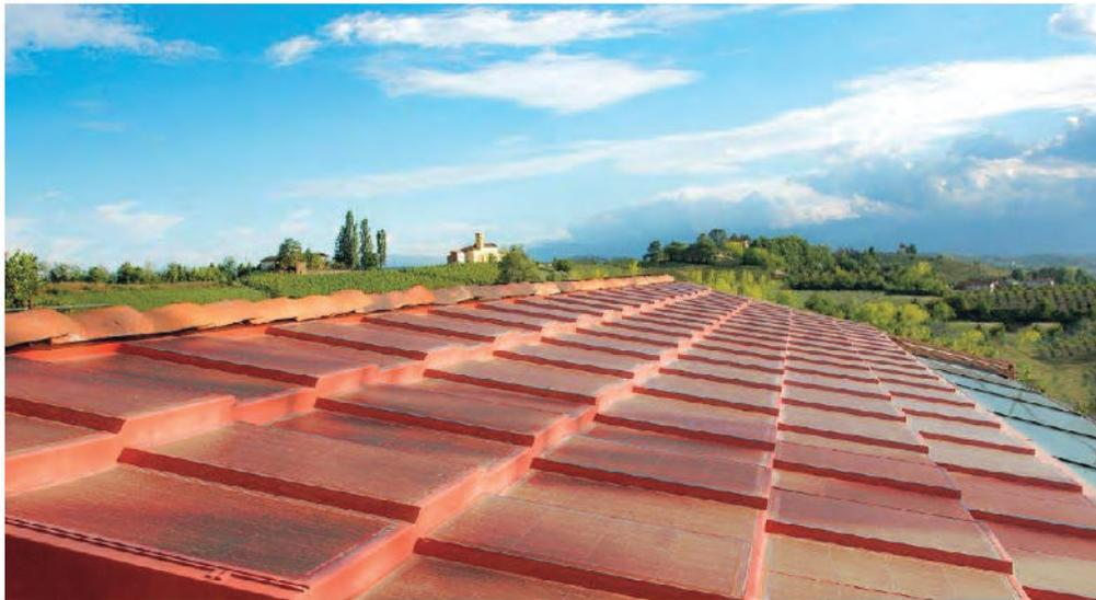
**Descrizione dell'intervento realizzato:** Applicazione della copertura SOLAR ROOF, tetto fotovoltaico estetico, copertura impermeabile e fotovoltaica nell'anno 2015 all'interno di un territorio protetto patrimonio UNESCO.
