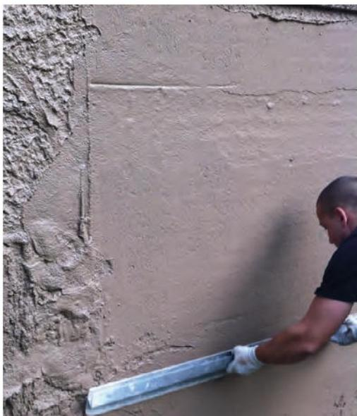
Internamente l'edificio è stato totalmente intonacato con Rudus Intonaco – Calchèra San Giorgio ed accuratamente lavorato in superficie per ottenere un fondo uniforme e compatto. Le finiture, colorate nella materia, sono state eseguite direttamente sull'intonaco asciutto: finitura liscia ad effetto opaco in parete con Vetus Marmonino – Calchèra San Giorgio e ad effetto più ruvido a soffitto con Tonachino – Calchèra San Giorgio.
