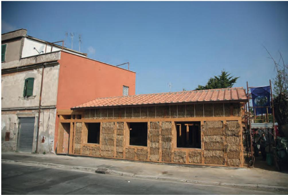
La struttura dell'edificio è stata realizzata con un telaio portante in legno, in parte pre-assemblato in stabilimento. Le tamponature sono realizzate in balle di paglia impilate una sull'altra nello spazio tra un pilastro e l'altro, il cui passo, laddove possibile, è stato studiato proprio sulla dimensione delle balle per rendere più agevoli e veloci le lavorazioni in cantiere.
