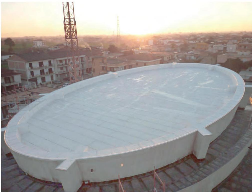
**Voce di capitolato:** Fornitura e posa in opera di membrana impermeabile ecosostenibile DERBIBRITE NT ottenuta con miscela HCB (Hybrid Copolymer Blend) a base di speciali copolimeri nobili additivati con sostanze ignifughe halogen free rispettose dell'ambiente e non tossiche. DERBIBRITE NT è provvista di armatura composita di velo di vetro e poliestere posizionata sulla parte superiore della sezione della membrana.
