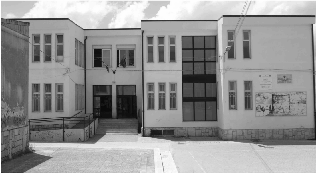
Fig. C-1 Foto prospetto NE.
