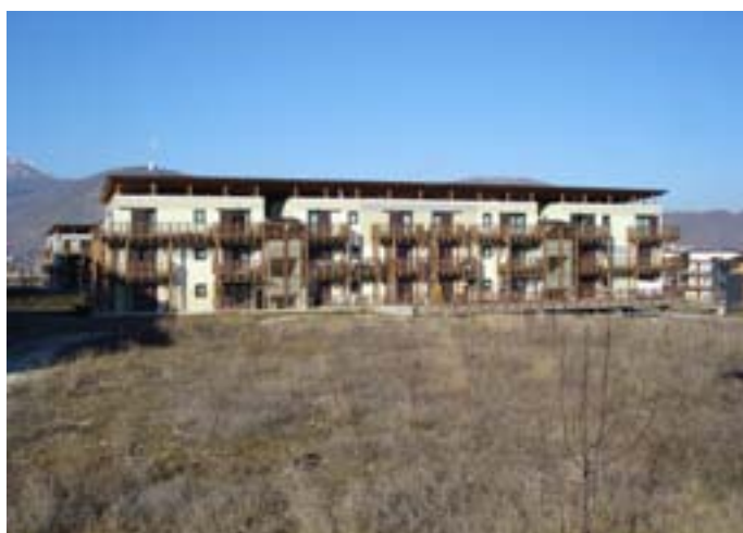
Foto 3 — Edificio del progetto CASE
