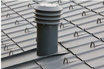
È di fondamentale importanza seguire attentamente le prescrizioni Prefa sia per la posa delle tegole che dei nastri Prefalz soprattutto in prossimità di camini e di Velux prestando molta attenzione ai raccordi e alle problematiche di dilatazione.
