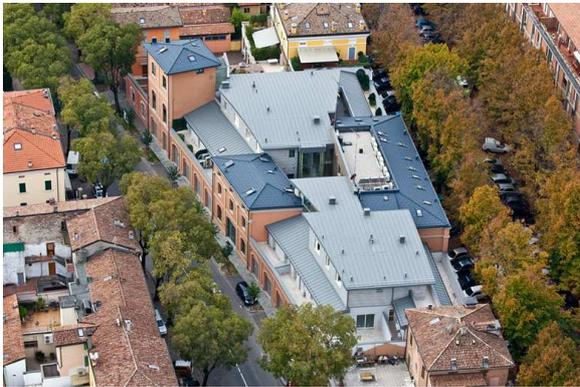
Tutte le coperture sono state realizzate con **manti discontinui in lamiera piane in alluminio preverniciato Prefa**, rivettate e risvoltate verticalmente all'interno.
