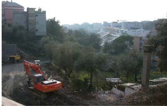
Lavori in corso a Villa Gambaro
