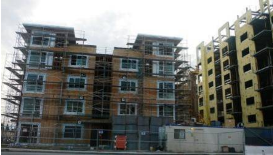
Nuove edificazioni a Giugliano in Campania (NA)
