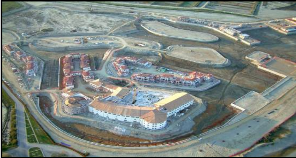
Il cantiere di "Marinagri"
