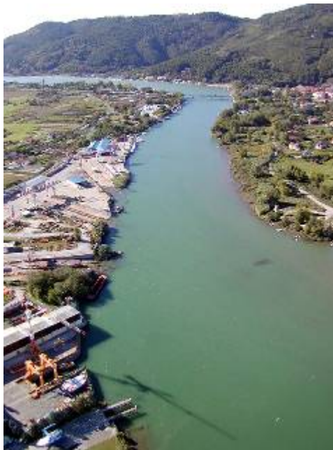
Cementificazione delle rive del Fiume Magra
