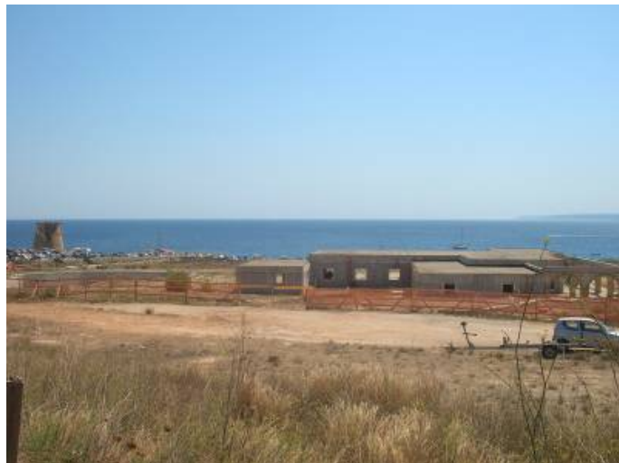
Il cantiere nel 2008 a Torre Porto Miggiano (LE)
