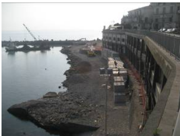
Lavori in corso per la realizzazione del nuovo porto di Diamante
