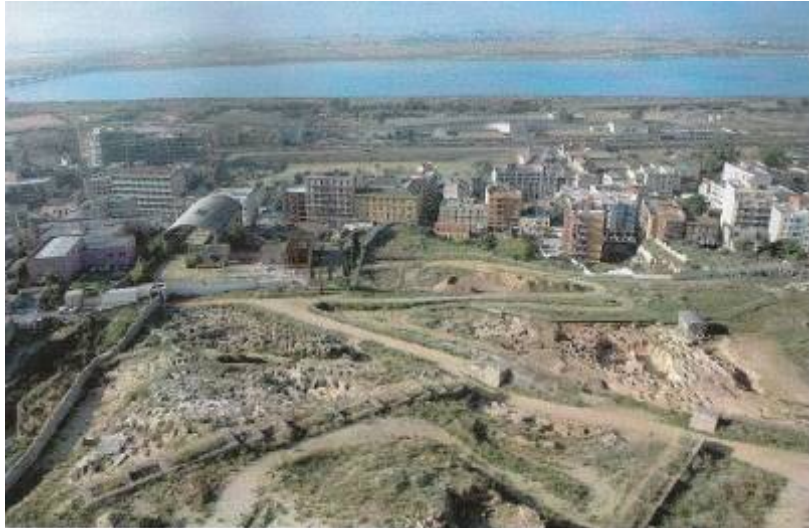
Vista dall'alto dell'area di Tuxeddu con le tombe fenicie, area per la quale è stato presentato un progetto per un quartiere residenziale
