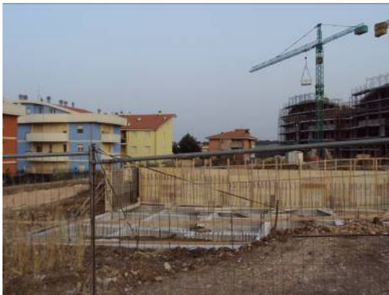
Cantieri e nuovi edifici a Termoli (CB)
