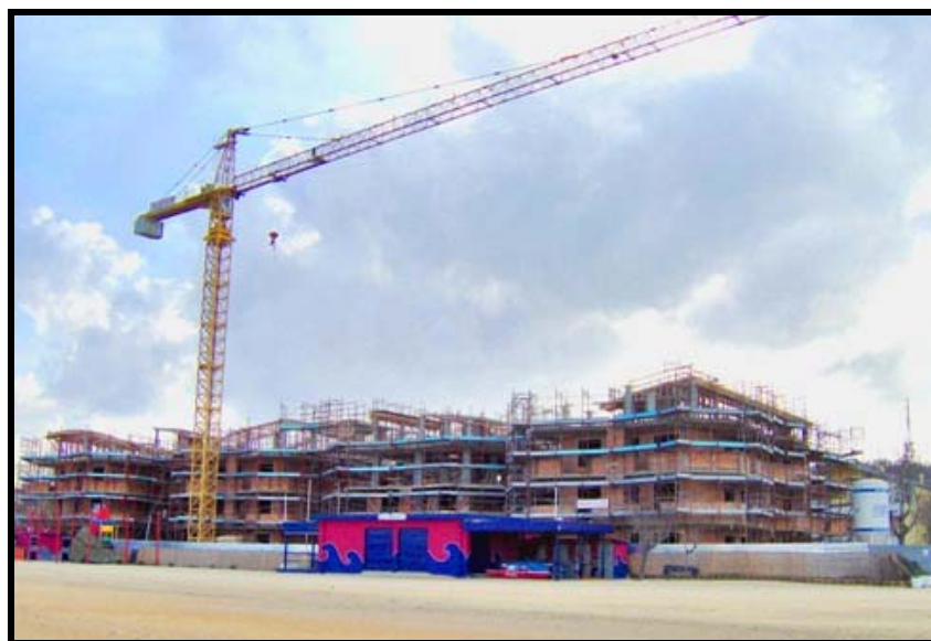
Il cantiere del Residence "Le Vele" di Francavilla al Mare (CH)
