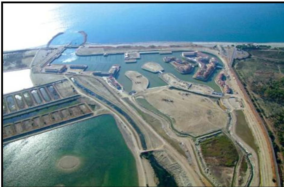
Il complesso turistico in costruzione
