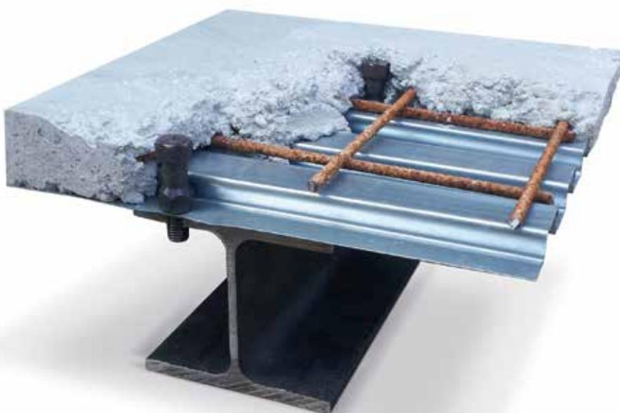
Durante l'installazione il connettore solca l'acciaio filettandolo
