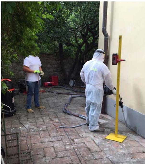
La metodologia proposta da SYSTAB è un Sistema esclusivo basato sull'iniezione nel terreno, al di sotto della fondazione, di resine bicomponenti fortemente espansive ed in grado di ottenere:
