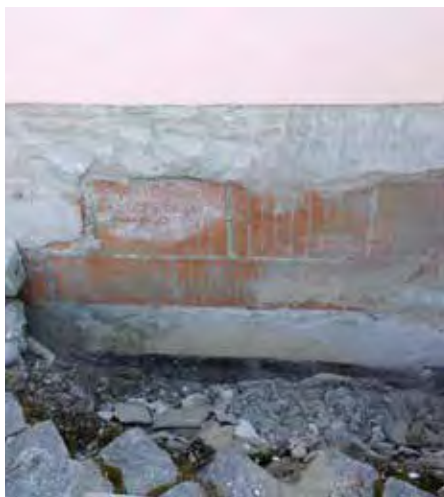
Danno della zoccolatura da ristagno
