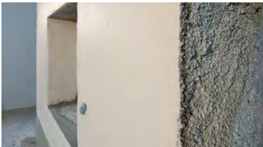
Applicazione del rivestimento (RÖFIX 380)
