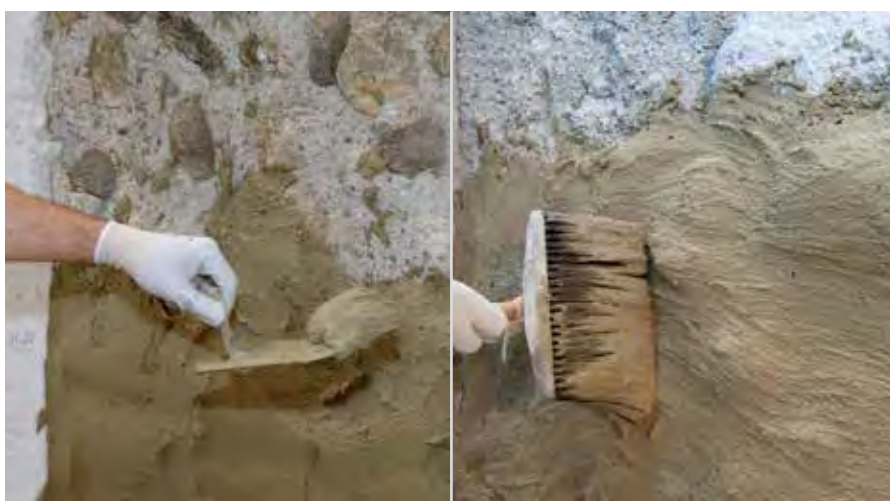
Applicare in modo irregolare RÖFIX 635
