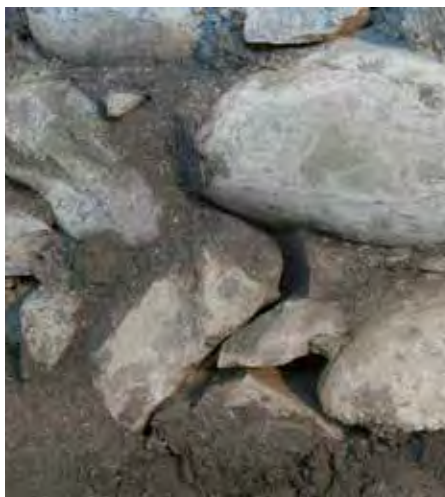
Cavità nella muratura in pietra naturale
