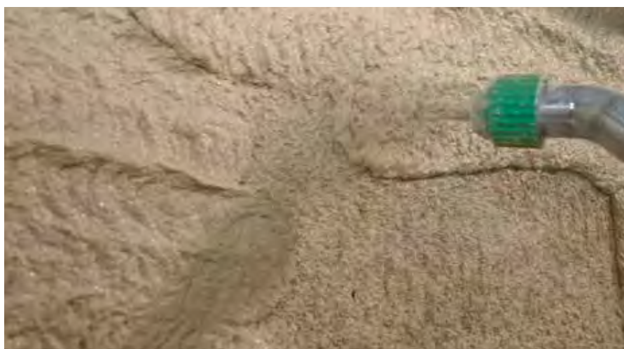
Applicazione di RÖFIX CalceClima® Thermo
