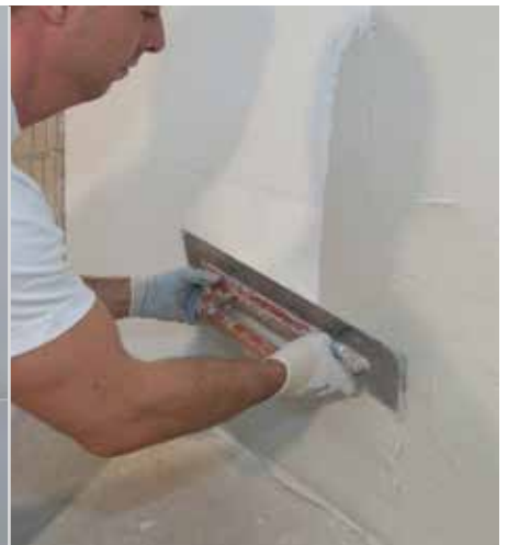
Rasatura con RÖFIX Renopor® Collante e rasante specifico
