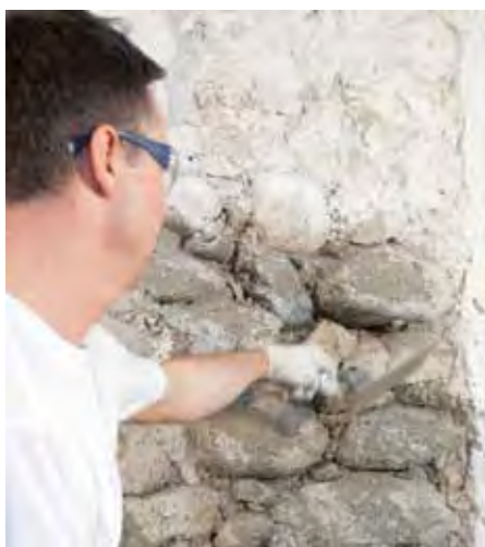
Applicazione di RÖFIX 671 Malta da rinzafo per risanamento su 60% della superficie
