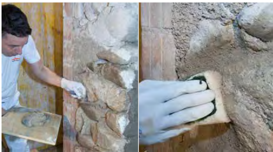
Riempimento di fughe di murature in pietra naturale Pulire i lati della pietra con una spugna umida
