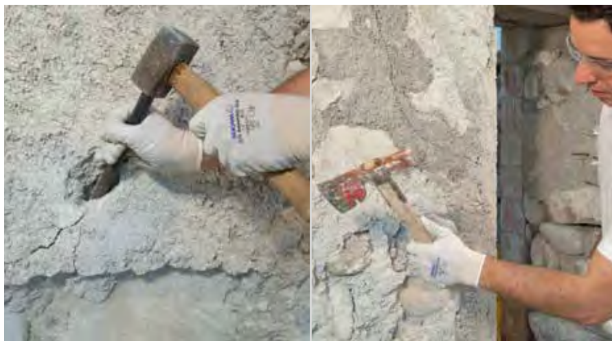
Rimozione dell'intonaco vecchio
