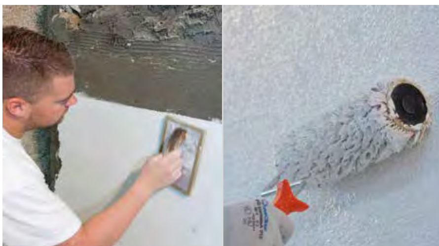
Strutturare e rifinire RÖFIX 340/341
