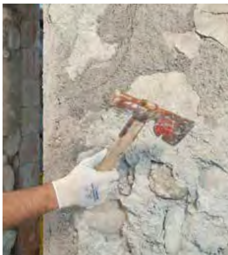
Rimuovere l'intonaco vecchio
