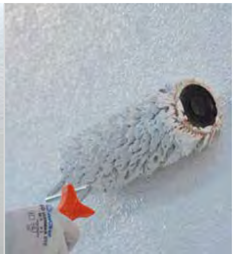
Rivestimento con pitture permeabili al vapore
