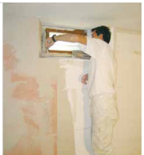
Montaggio con RÖFIX Renopor® Accessorio cuneiforme per soffitti
