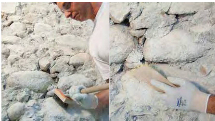
Scoprimento e pulizia della muratura.
