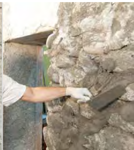
Applicazione di RÖFIX 648 Intonaco antisale
