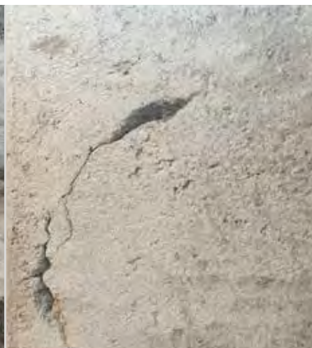
Cavità nell'intonaco vecchio
