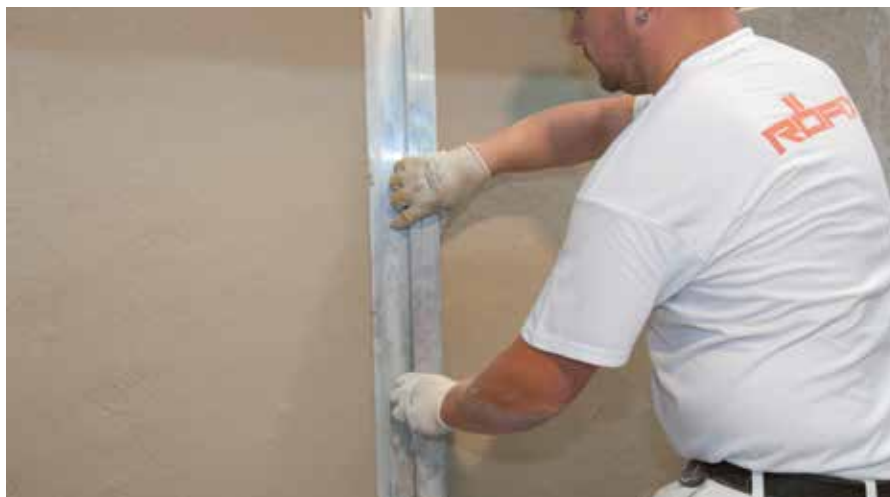
Rasatura di RÖFIX CalceClima® Thermo
