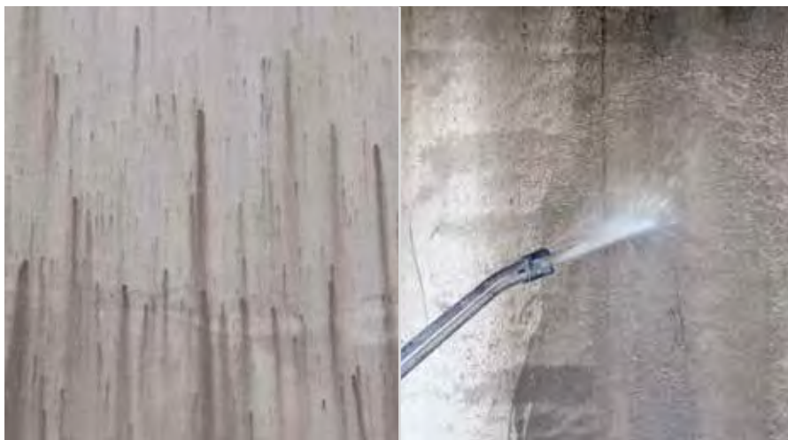
Intonaco di facciata infestata con alghe/funghi
