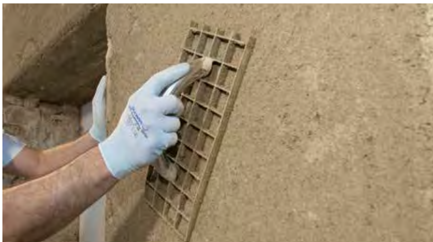
Levigatura di RÖFIX CalceClima® Ambiente con RÖFIX Rabbot
