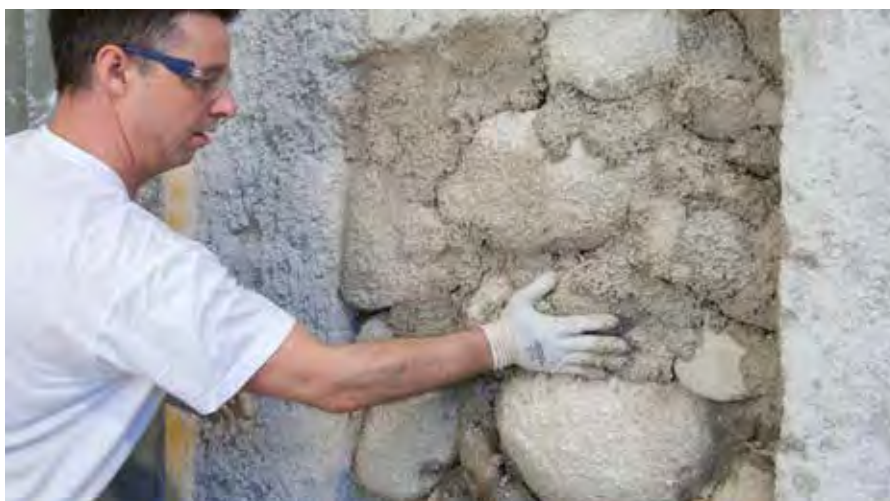
Chiusura di punti difettosi e cavità
