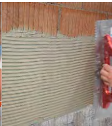
Rasatura sopra striscia adesiva
