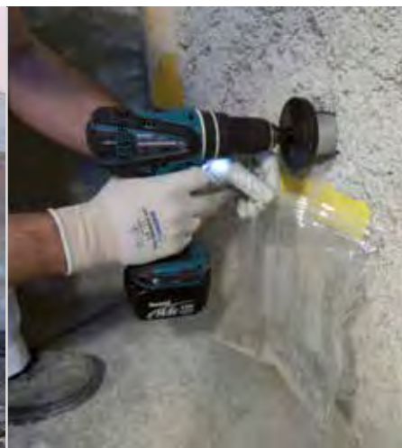
Prova dell'intonaco a contenuto salino
