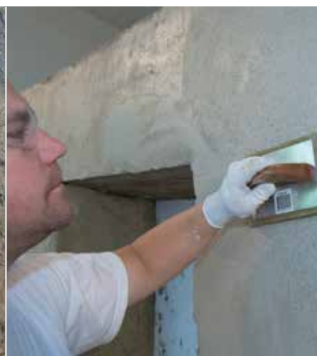
Strutturazione di RÖFIX 397
