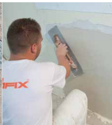
Compensare irregolarità di intonaco
