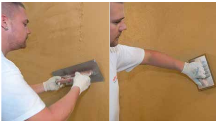
Applicazione dello strato di finitura
