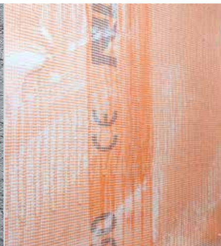
RÖFIX Renoplus® armatura con rete
