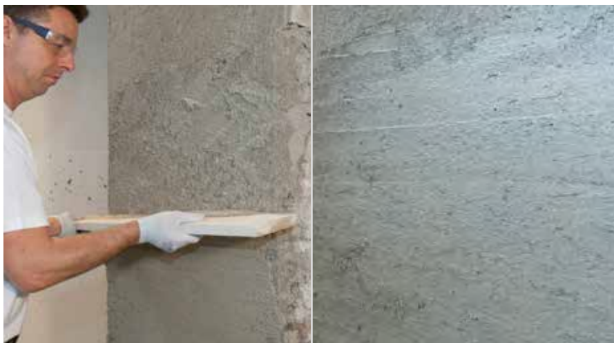
Staggiatura/irruvidimento del intonaco a base calce Strato irruvidito finito
