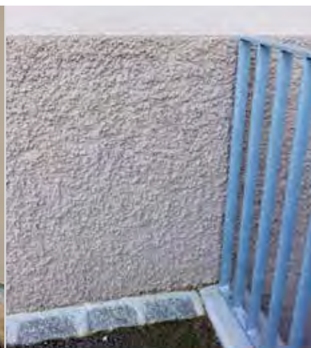
Zoccolatura visibile transizione facciata
