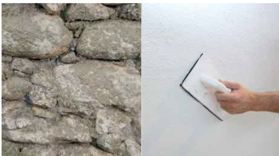
RÖFIX 671 Malta da rinforzo per risanamento su 60% della superficie
