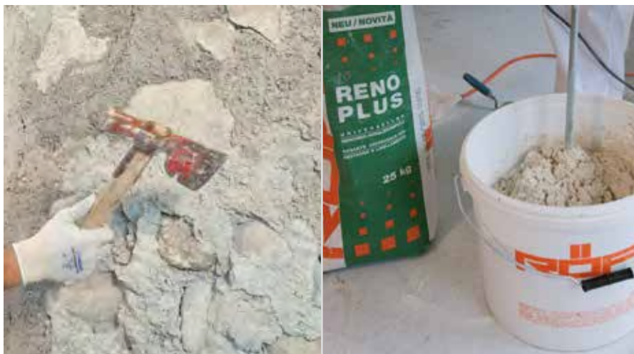
Rimozione dell'intonaco vecchio
