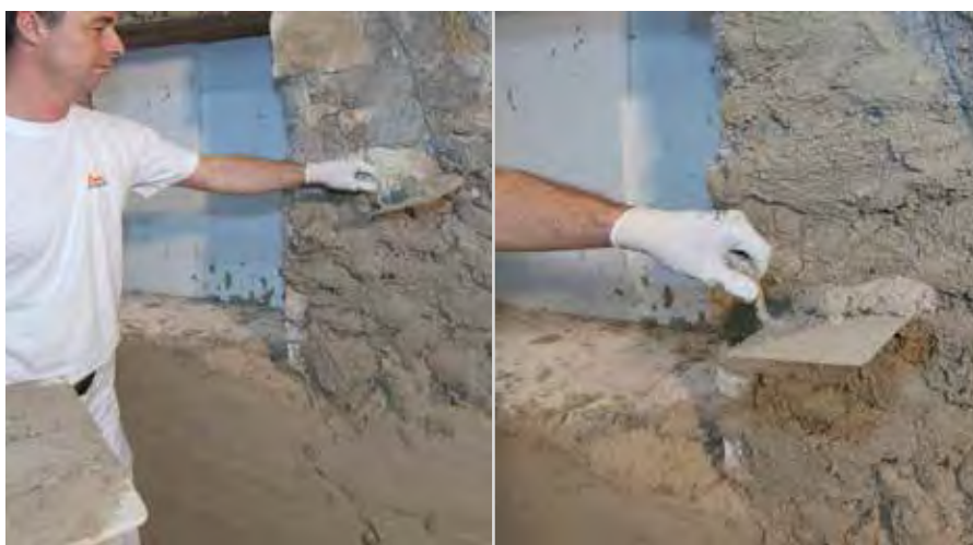
Applicazione dell'intonaco a base calce
