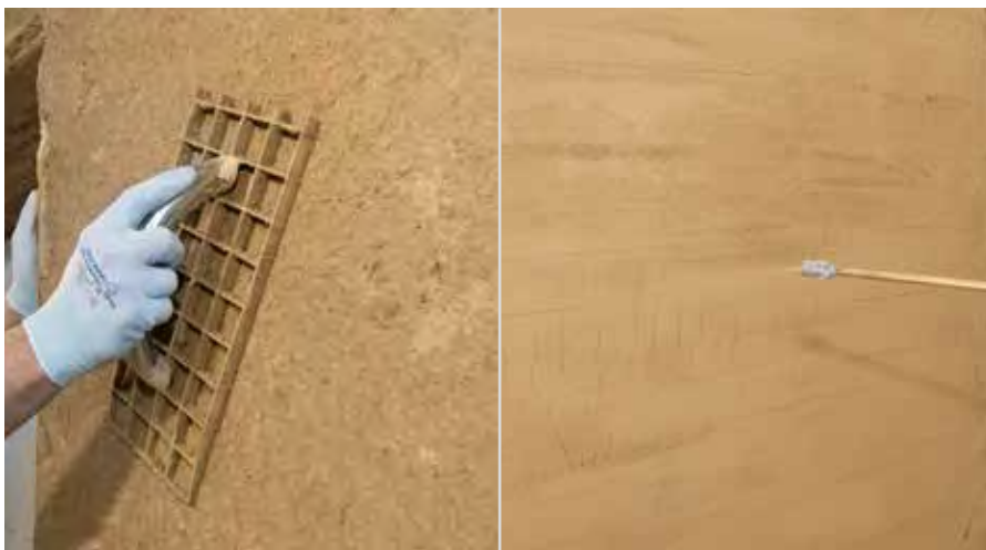
Levigatura e bagnatura di RÖFIX Geolehm®
