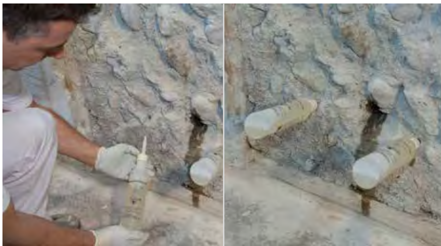
Iniettare RÖFIX Cavastop 10–15 cm superiore del pavimento
