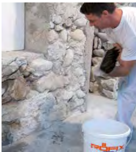
Applicazione RÖFIX Primer risanante con spazzola
