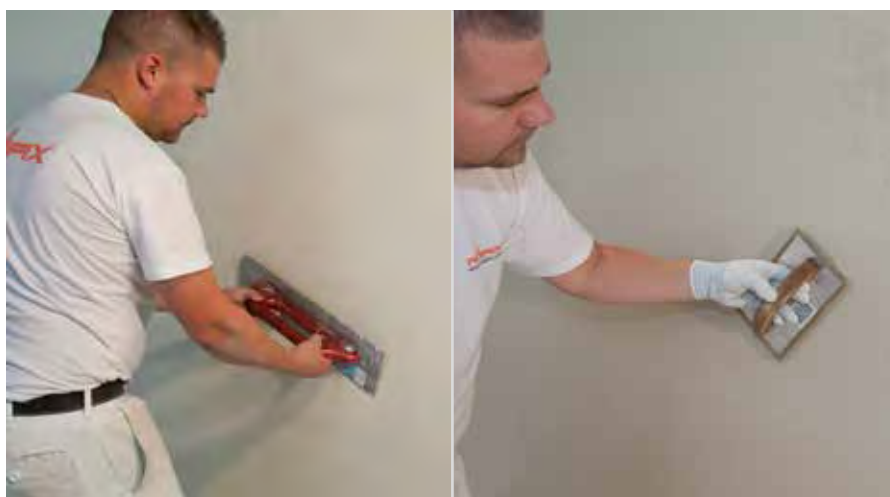
Applicazione del rivestimento minerale RÖFIX CalceClima® Fino
