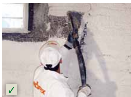
Livellamento del supporto prima del rivestimento definitivo (nuova pittura, rivestimento murale) RÖFIX Renostar®
