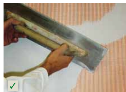
Strato di armatura in caso di supporti problematici RÖFIX Renostar® RÖFIX Renoplus®
