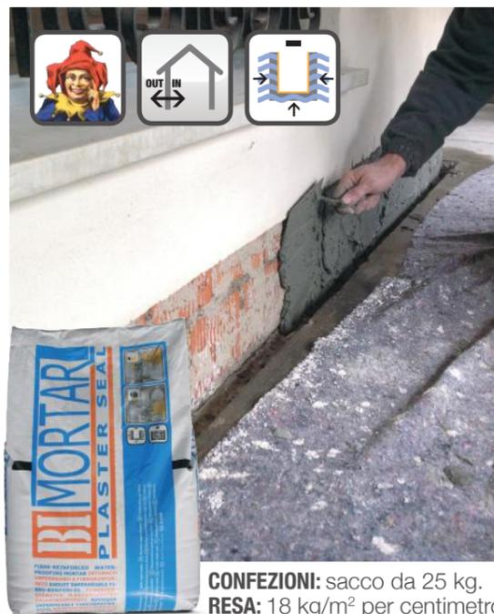
Intonaco impermeabile a spessore che impermeabilizza e, al contempo, regularizza sia murature miste che in calcestruzzo armato.
