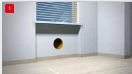
**2)** Inserire un tubo in PVC leggero bianco, di quelli comunemente usati per realizzare le aperture di ventilazione. (dis. 2)
