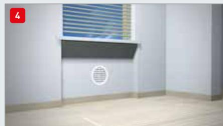
**5)** Posizionare le griglie (non incluse nella confezione) (dis. 4). Nella scelta del tipo di griglia occorrerà prestare attenzione all'ingombro del sistema di ancoraggio, il quale dovrà essere inferiore alla distanza **d** (dis. 5) che intercorre tra l'estremità di Isolmant Tubo e l'estremità del tubo in PVC, sia sul lato interno che su quello esterno della parete.
