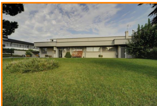
Sede Amministrativa e Produttiva
