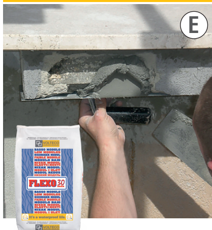
RIPRISTINO INTONACO BALCONI pag.10
