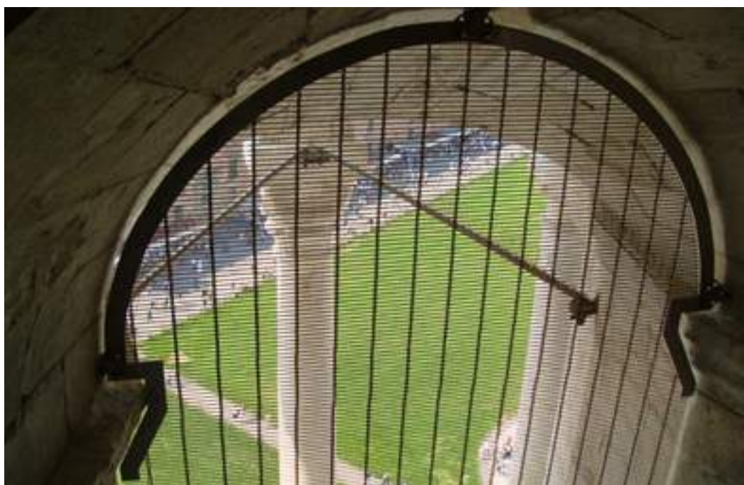
Protezione anti-volatili Torre di Pisa Pisa, Italia Progetto Sovraintendenza ai beni culturali e artistici Installazione Infissi Giorgetti S.r.l. Tela metallica A.303
