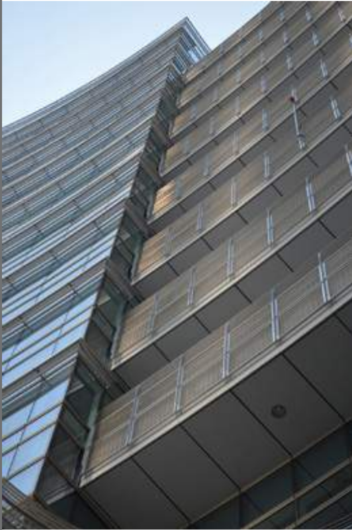
Torri Porta Nuova Milano, Italia Progetto Arch. César Pelli Installazione Permasteelisa S.p.A. Tela metallica I.107
