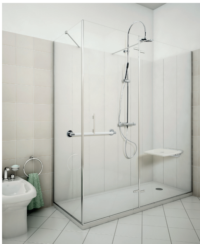
Risultato dopo l'intervento, con rivestimento alto in pietra acrilica
