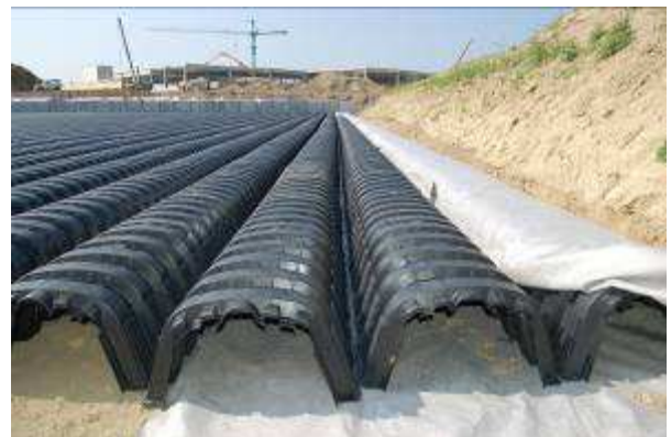
Figura 15 - Posa del geotessuto sul perimetro dello scavo
