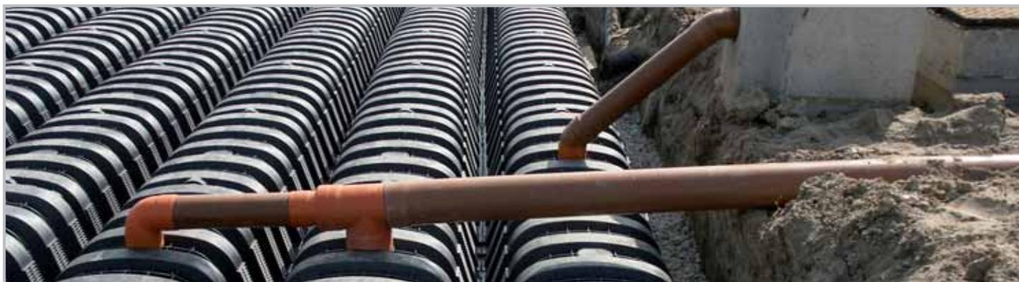
figura 9) Esempio di innesto dei tubi sulla sommità del sistema **DRENING®**.
