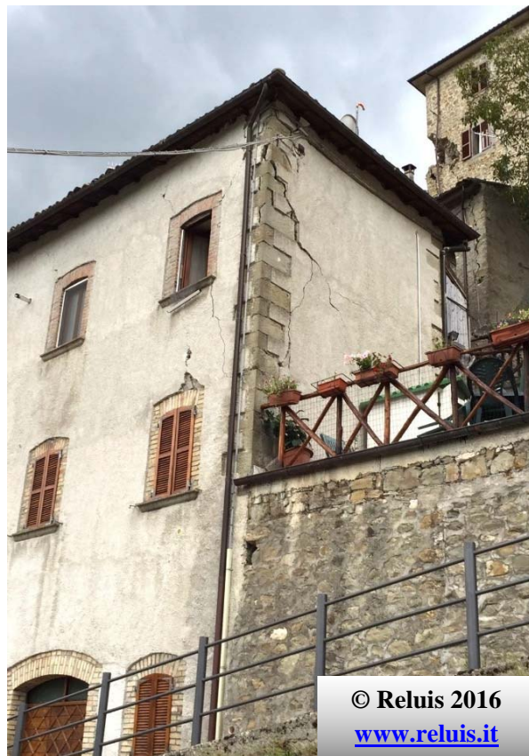
Edifici privati. Danno limitato al cantonale. Nel caso a sinistra si evidenzia la presenza di numerosi tiranti e dell'espulsione fuori piano del paramento esterno in pietra
