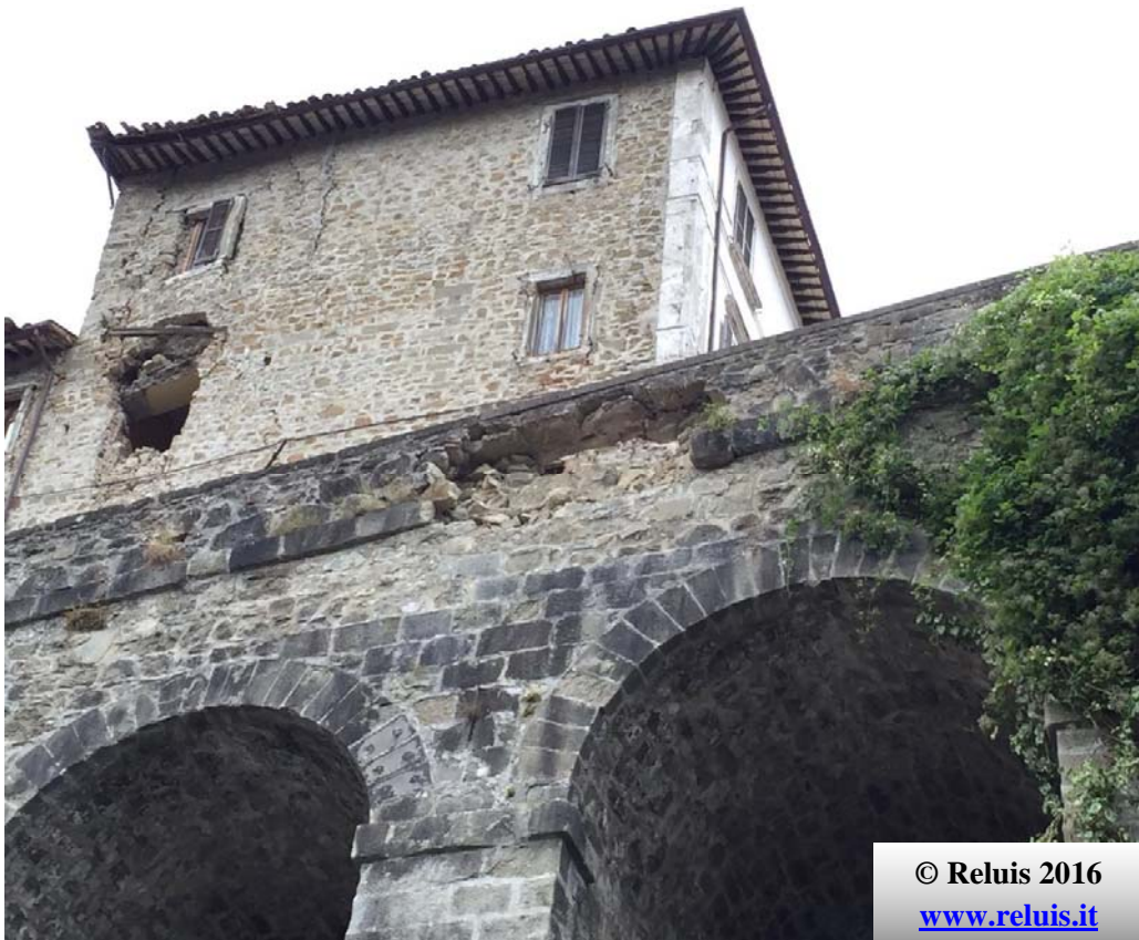
Infrastrutture stradali. Collasso di porzioni di parapetto. Sull'edificio in secondo piano si nota uno spanciamiento con innescio di fuori piano e crolli locali
