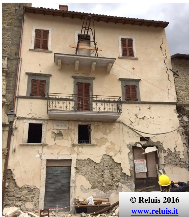
Edificio privato in aggregato. Presenza di danno diffuso al piano terra con distacco dell'intonaco. Si evidenzia la deformazione della porta al piano terra e la sua posizione alla base del maschio murario
