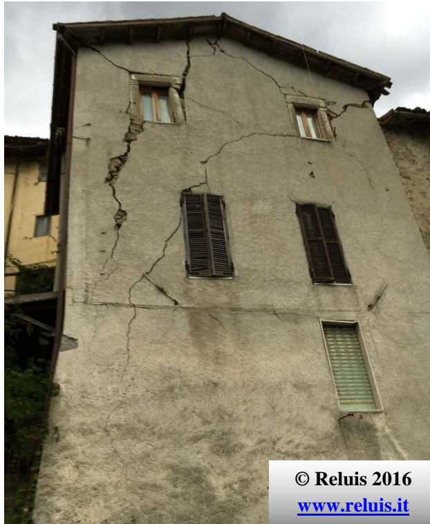
Edificio residenziale in aggregato. Danno diffuso nel piano
