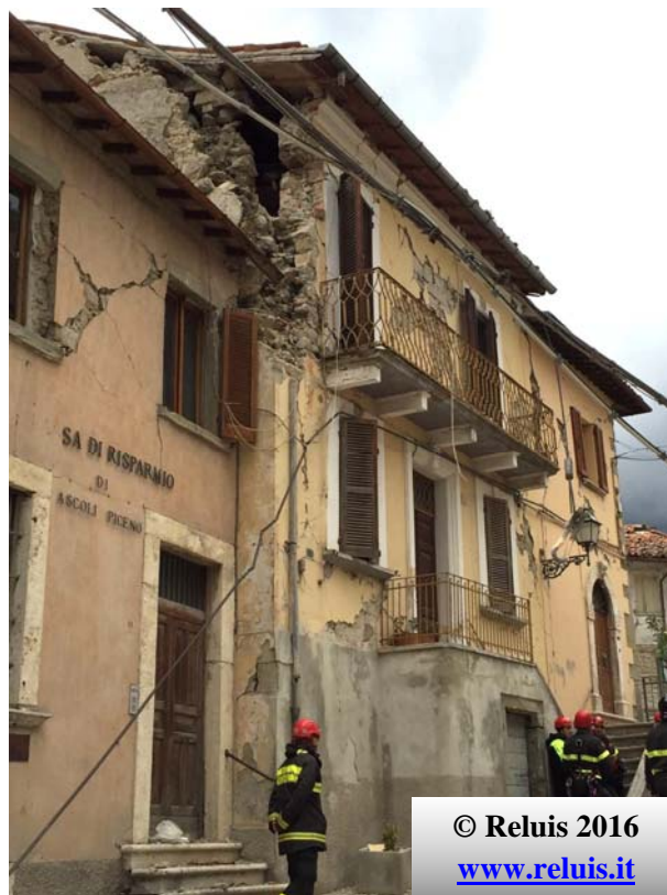
Edificio privato in aggregato (adiacente all'edificio bancario). Collasso fuori piano del cantonale in prossimità della copertura. Presenza di lesioni nel piano sui maschi murari e diffusi distacchi dell'intonaco
