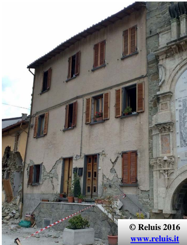
Edificio residenziale in aggregato. Danno nel piano localizzato ai maschi murari del piano terra
