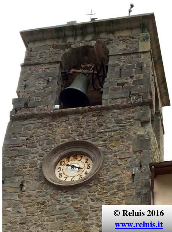
Torre civica in piazza Umberto I. Rotazione della cella campanaria con conseguenti lesioni alla base dei piedritti. Presenza di catene sulla torre.
