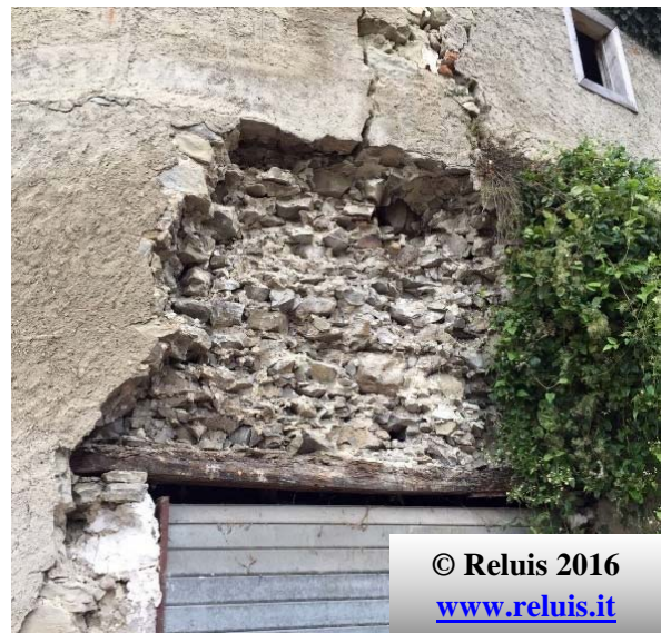
Edificio privato. Innesco del meccanismo di fuori piano e collasso del paramento esterno in pietra nella porzione sovrastante l'apertura
