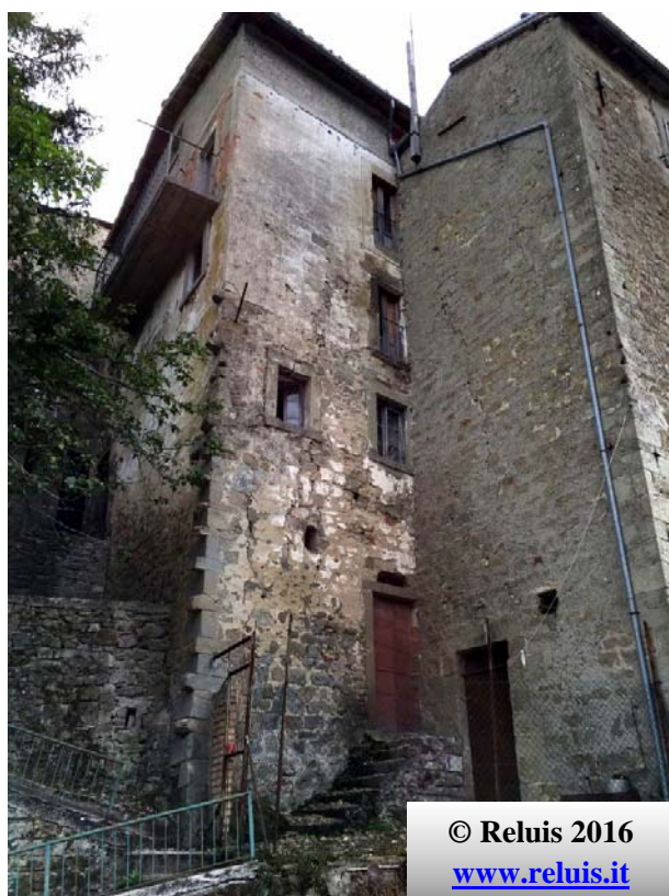
Edifici residenziali in aggregato. Danno limitato e presenza di presidi antisismici, tiranti
