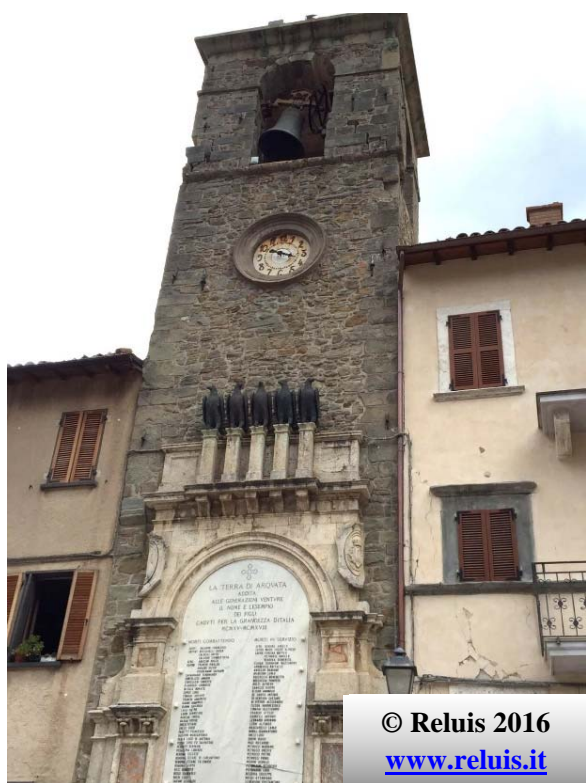
Torre civica in piazza Umberto I. Rotazione della cella campanaria con conseguenti lesioni alla base dei piedritti. Presenza di catene sulla torre.
