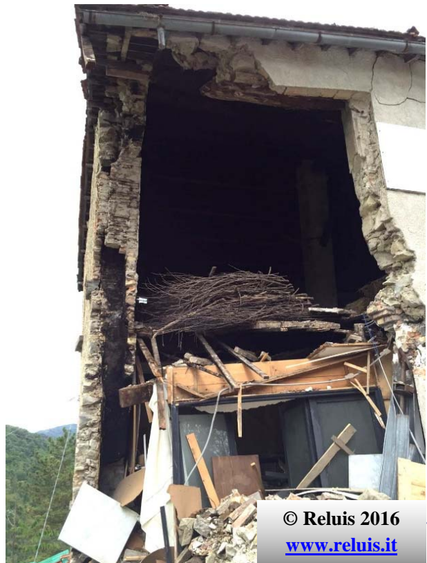
Edificio rurale. Collasso della porzione angolare legato alla presenza di grandi aperture e della canna fumaria
