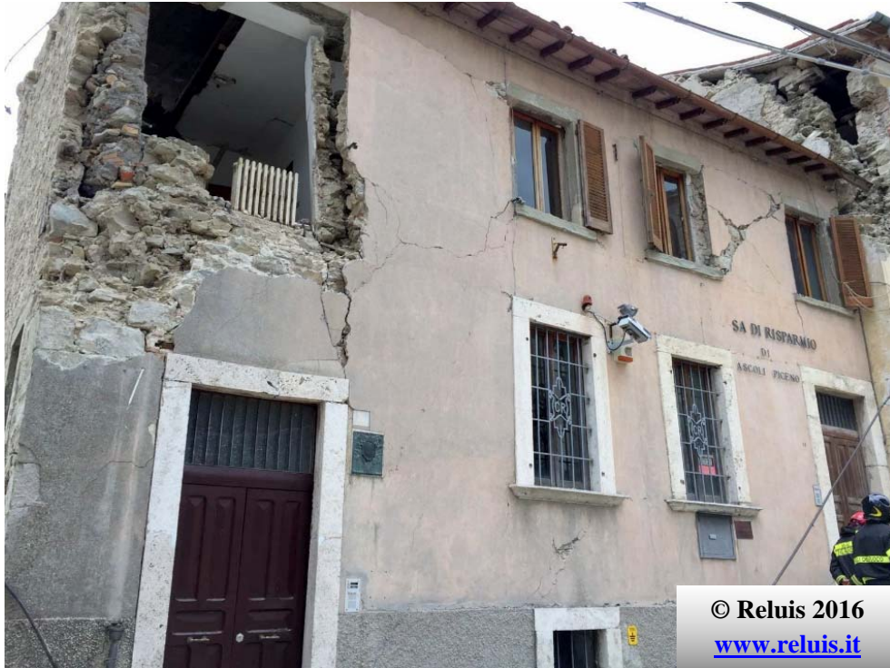
Edificio bancario in aggregato. Lesioni a taglio localizzate principalmente nei maschi murari del piano superiore con espulsione fuori piano della porzione angolare. Si evidenzia il distacco tra i paramenti murari in pietra
