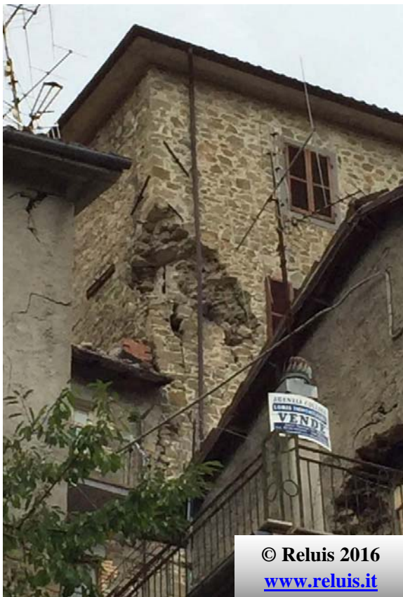
Edifici privati. Danno limitato al cantonale. Nel caso a sinistra si evidenzia la presenza di numerosi tiranti e dell'espulsione fuori piano del paramento esterno in pietra
