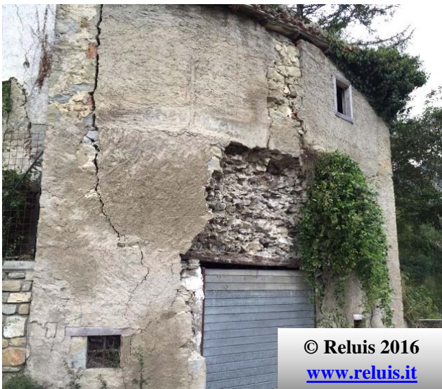
Edificio privato. Innesco del meccanismo di fuori piano e collasso del paramento esterno in pietra nella porzione sovrastante l'apertura
