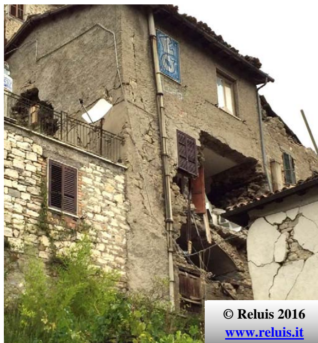
Edificio residenziale in aggregato. Espulsione fuori piano localizzata al piano terra e piano primo. Presenza al piano terra di una volta a botte in pietra
