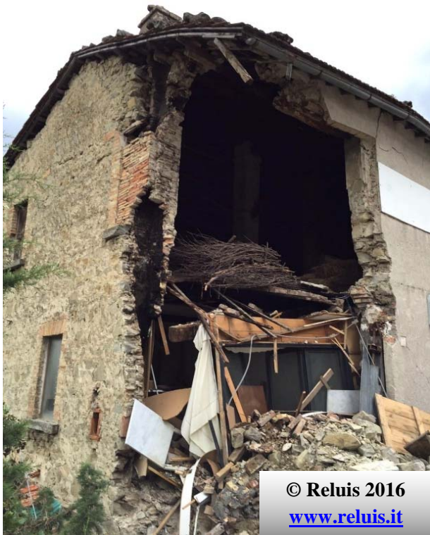
Edificio rurale. Collasso della porzione angolare legato alla presenza di grandi aperture e della canna fumaria
