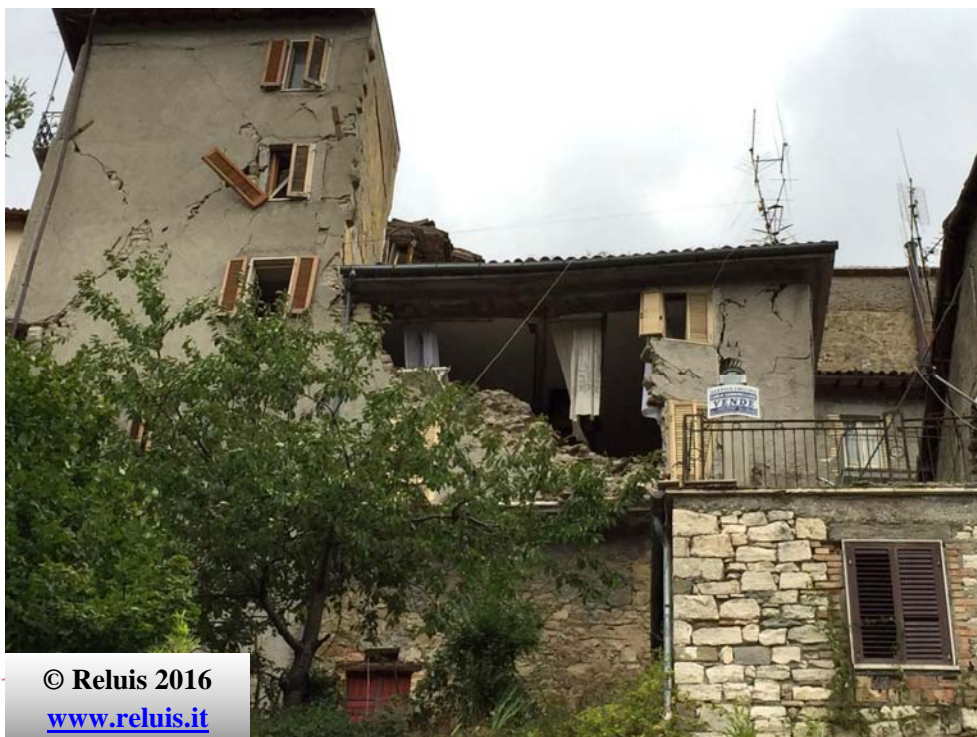
Edifici residenziali in aggregato. Edificio snello con presenza di tiranti e danno esteso nel piano. Spanciamento ed espulsione fuori piano della parete dell'edificio più basso
