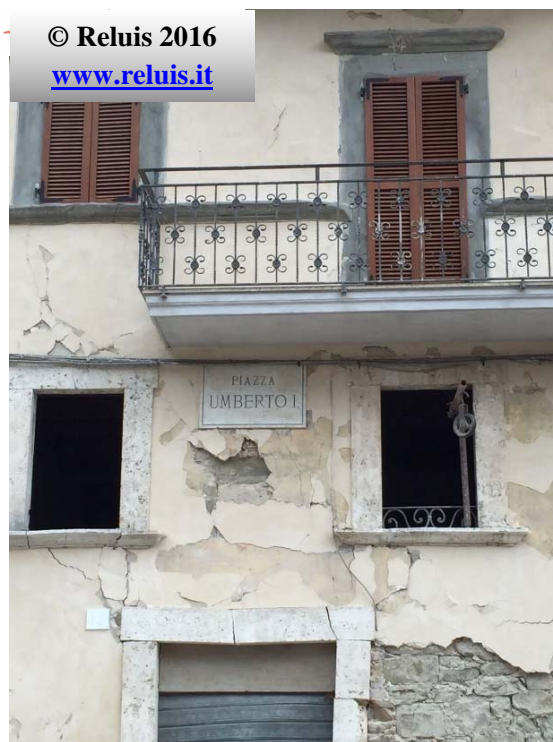
Edificio privato in aggregato. Presenza di danno diffuso al piano terra con distacco dell'intonaco. Si evidenzia la deformazione della porta al piano terra e la sua posizione alla base del maschio murario
