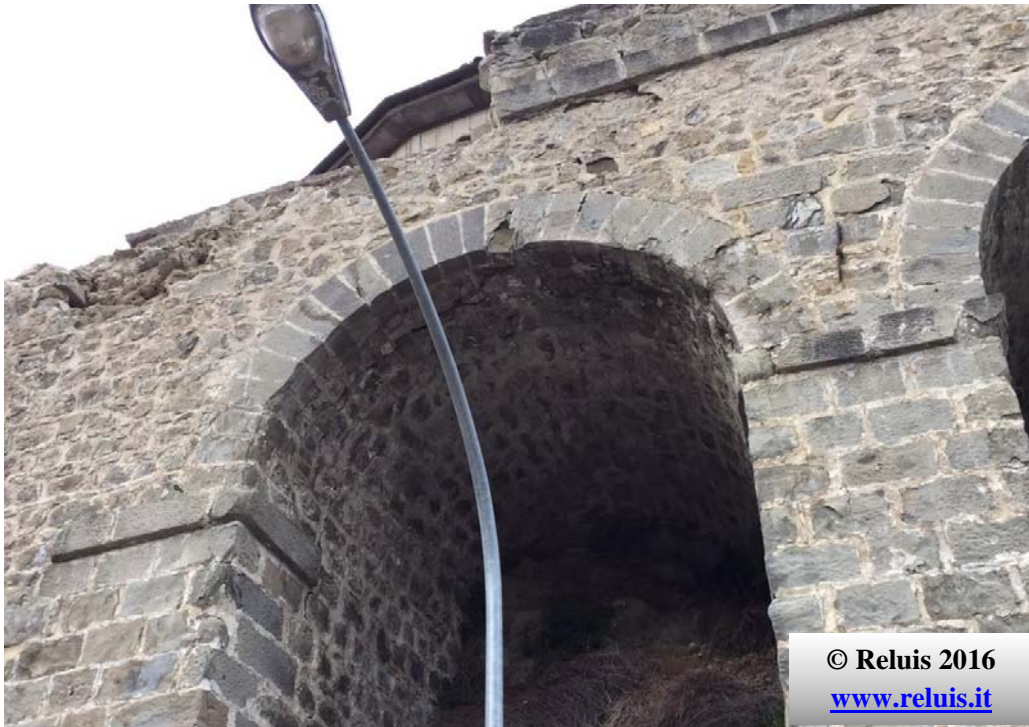
Infrastrutture stradali. Collasso di porzioni di parapetto e lesioni all'intradosso delle volte
