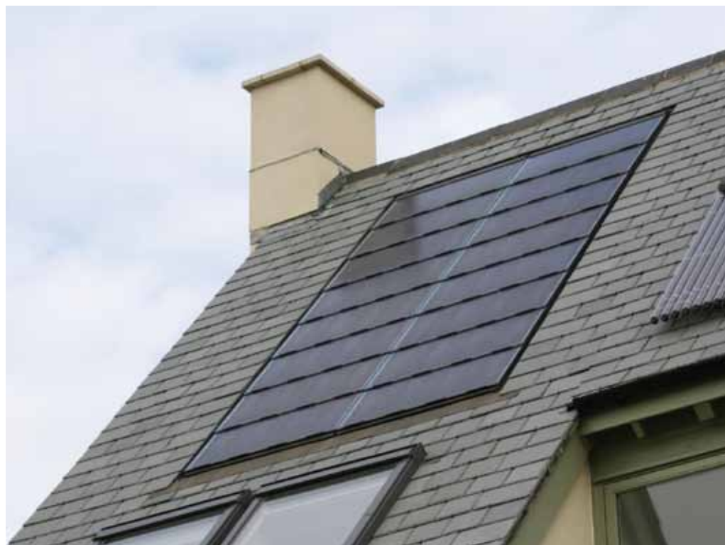
Pannello solare termico integrato su abitazione privata
