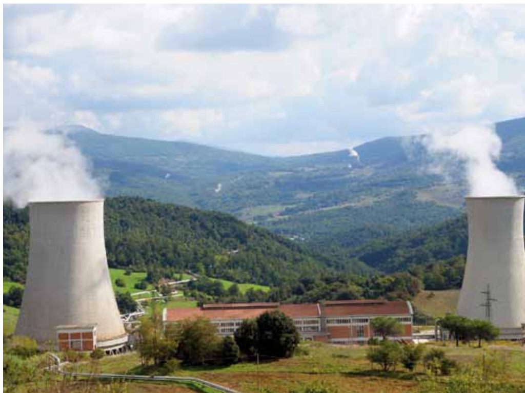
Centrale geotermica nel Comune di Pomarance (PI)
