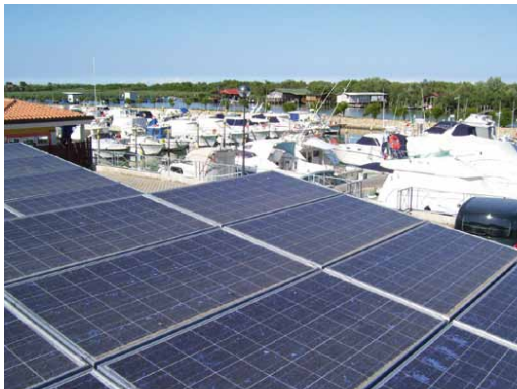
Impianto fotovoltaico su pensilina del parcheggio di Porto Barricata, Comune di Porto Tolle (RO)
