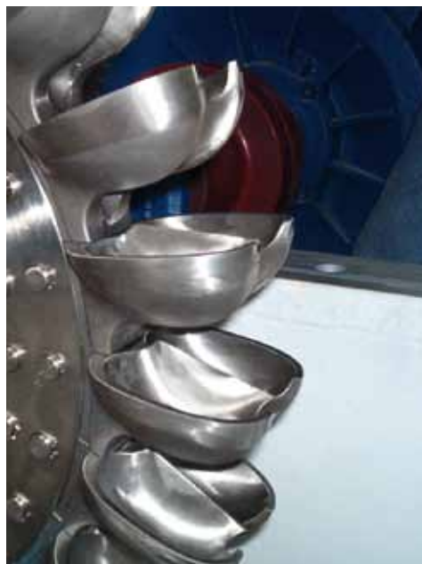
Particolare dell'impianto mini idroelettrico sull'acquedotto "Focobon" nel Comune di Falcade (Bl)
