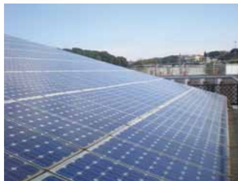
Tetto fotovoltaico sulla sede del GSE
