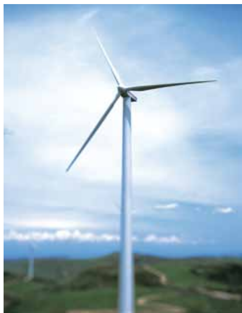
Impianto eolico nel Comune di Sedini (SS)
