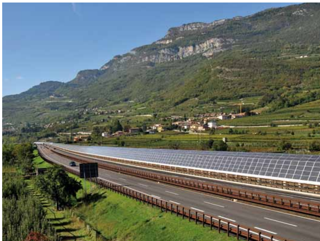
Pannelli fotovoltaici installati sulla barriera fonoassorbente sull'autostrada del Brennero, Comune di Isera (TN)
