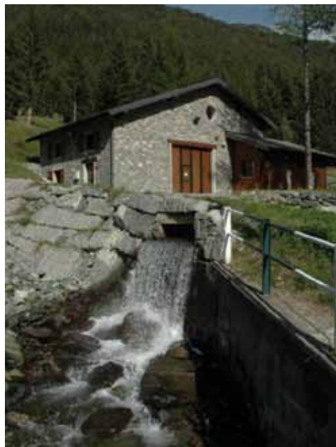
Impianto mini idroelettrico "Entovasco" nel Comune di Chiesa in Valmalenco (SO)
