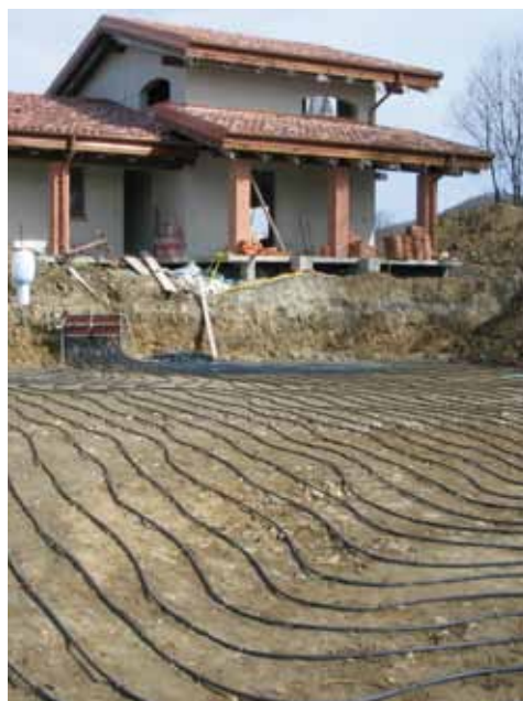
Impianto geotermico orizzontale nel Comune di Settimo Rottaro (TO)
