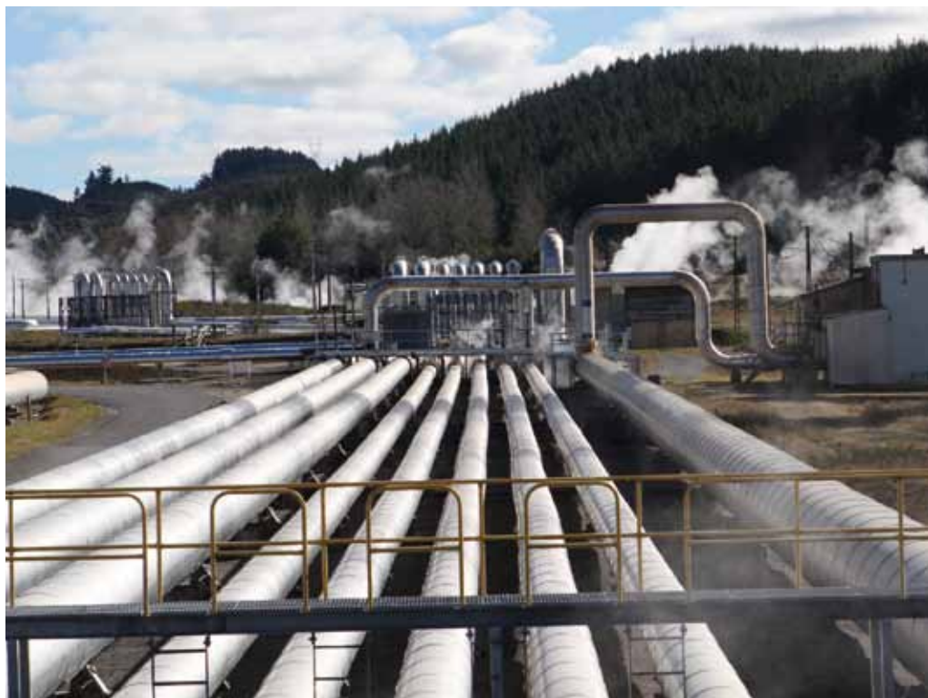
Particolare delle tubazioni di una centrale geotermica
