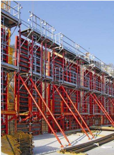
Figura 4: La nuova piattaforma di servizio MXP permette di lavorare sulla cassaforma in piena sicurezza. (Foto: PERI GmbH)
