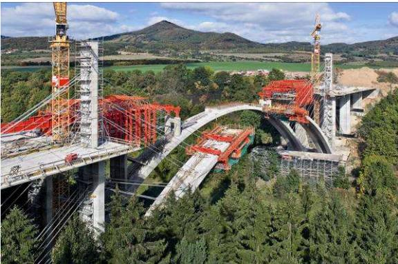
Figura 9: Il carro di varo ideato da PERI ha dimostrato la sua efficienza già durante la costruzione del ponte Oparno nella Repubblica Ceca. (Photo: PERI GmbH)
