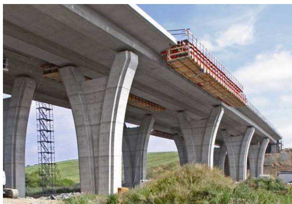
Figura 7: L'uso della piattaforma scorrevole per cordoli di un impalcato GKB amplia lo spettro delle applicazioni del VARIOKIT nel campo della costruzione di ponti. (Photo: PERI GmbH)
