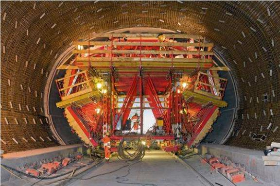
Figura 8: Grazie alla possibilità di noleggio, le casseforme traslabili VARIOKIT per tunnel offrono una alternativa vantaggiosa dal punto di vista economico anche nel campo delle gallerie Bergmann (Photo: PERI GmbH)
