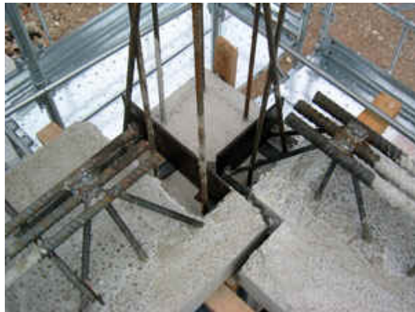
Fig. 3 - Appoggio delle travi reticolari sulle strutture perimetrali.
