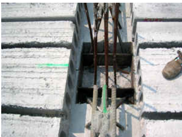
Fig. 4 - Appoggio del solaio alveolare sulle travi reticolari.
