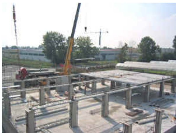
Fig. 6 - Vista del cantiere.
