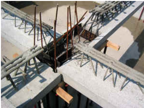
Fig. 2 - Incrocio delle travi reticolari.
