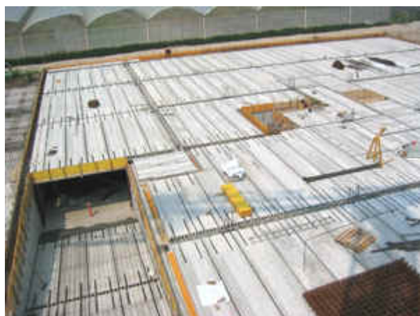
Fig. 5 - Vista del primo impalcato realizzato con solai alveolari e travi TLQ.
