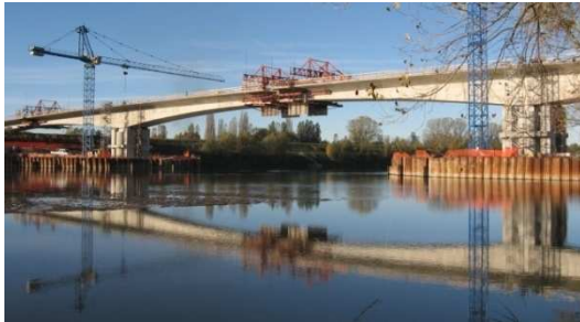
Viadotto sull'Adige (VR) Lombardi-Reico srl
