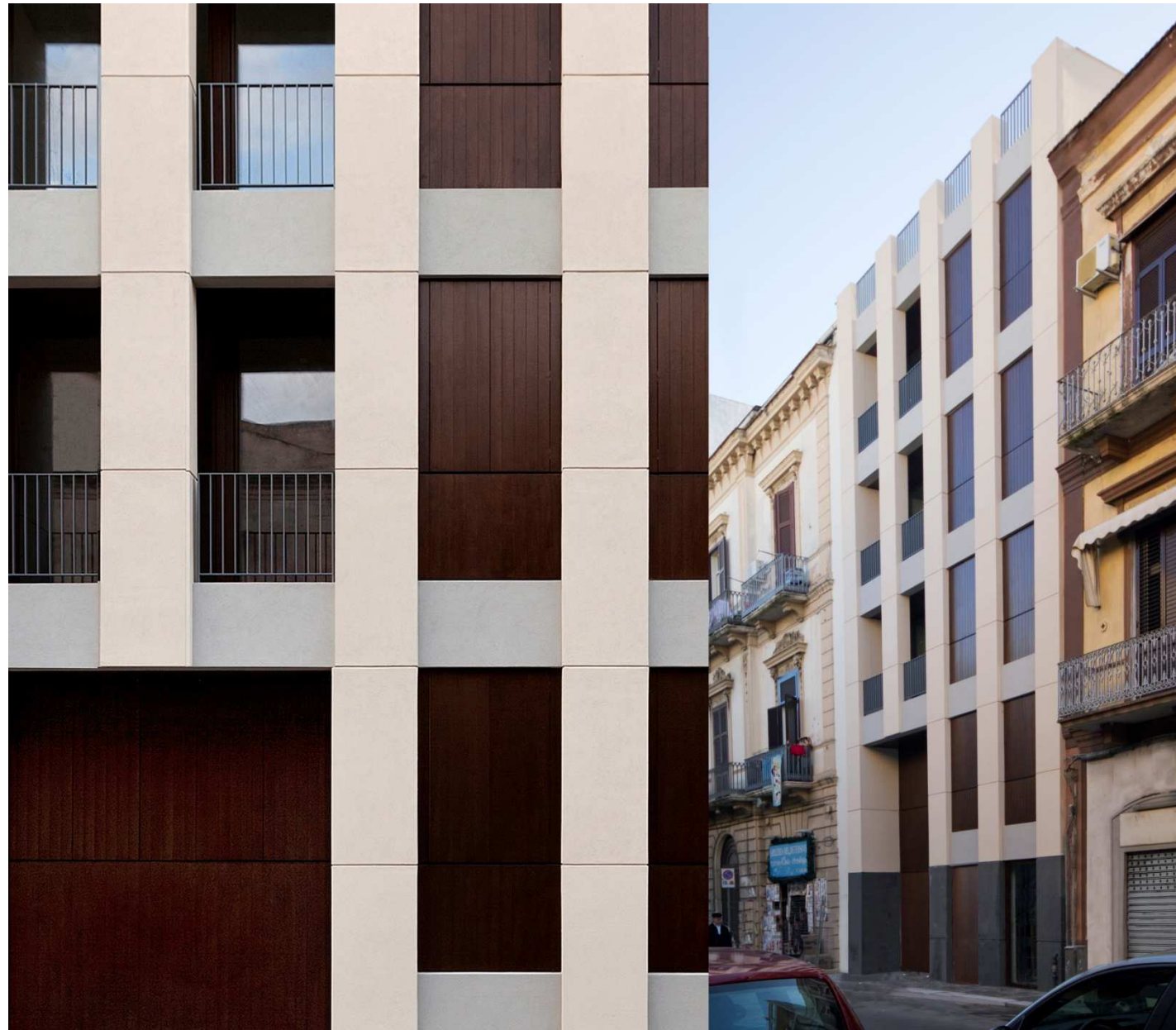
Edificio Residenziale: prog. Arch. L. Netti/ controllo e fisica tecnica arch. S. Paterno
