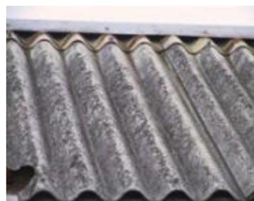
Anche nell'industria i pannelli divisorii o le tamponature erano spesso realizzati con materiali compositi dell'amianto con cemento, lane minerali, resine organiche e cellulosa.
