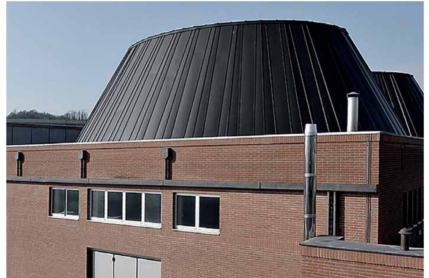
Distillerie Zanin - Zugliano, IT - 2015 Mavis: testa di moro - doppia aggraffatura Mavis: testa di moro - double standing seam
