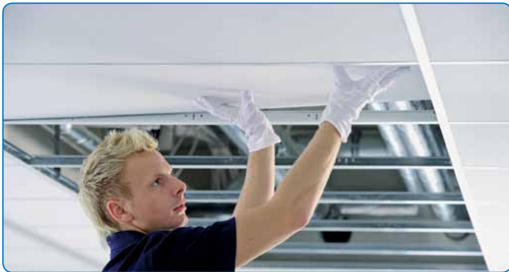
Figura 1.3 Esempio di installazione di un controsoffitto radiante
