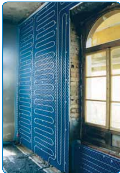
Figura I.5 Esempio di installazione di una parete radiante
